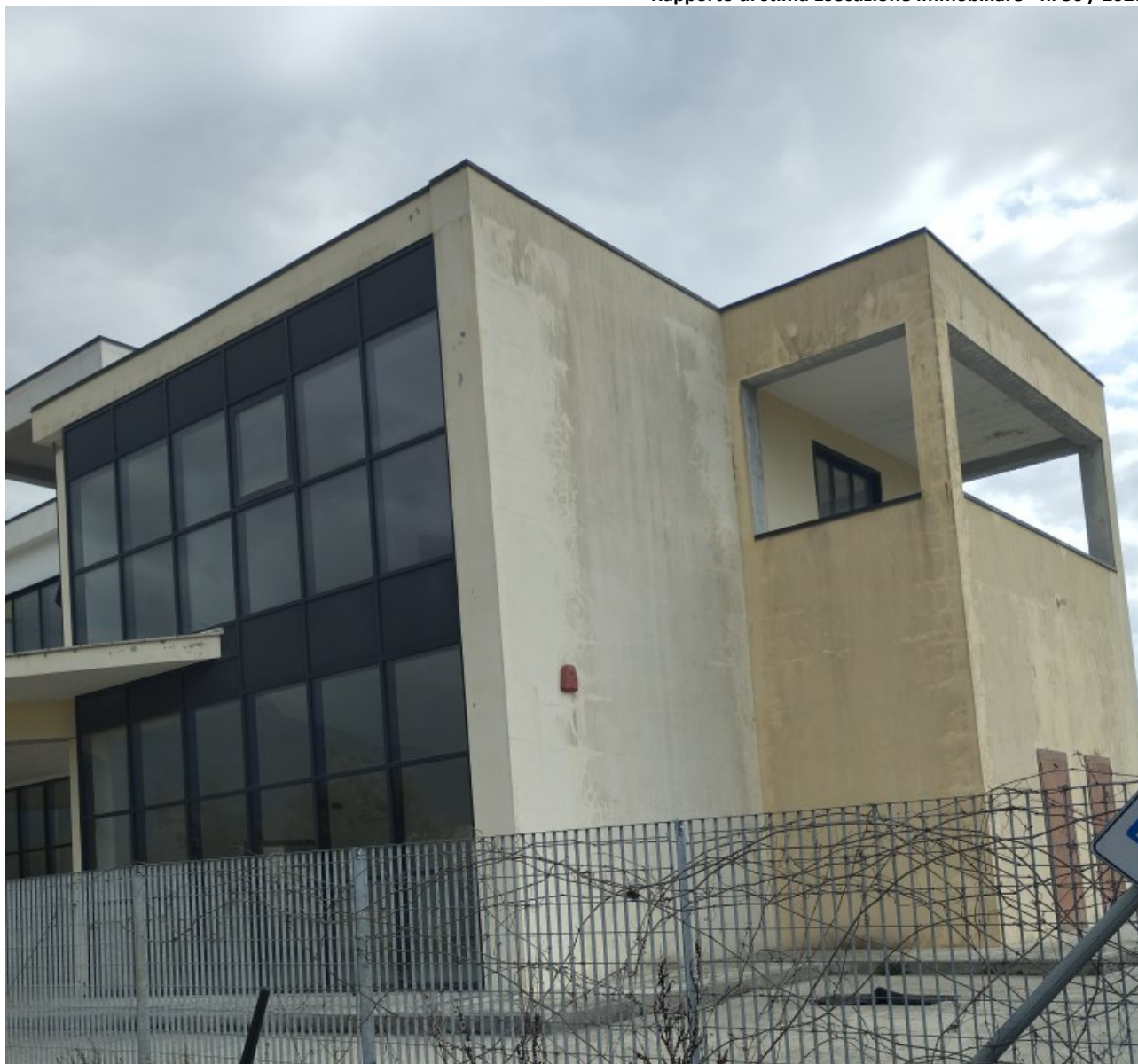
Edificio di proprietà comunale
