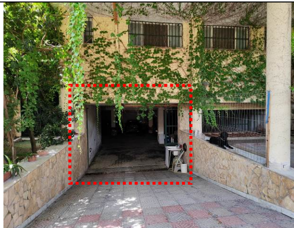
1 -Vista ingresso carrabile-
