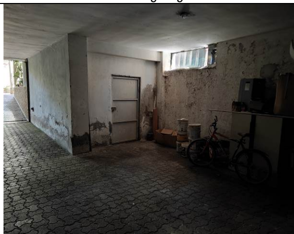
4 -Vista ingresso vano scala-
