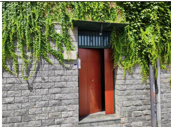
Accesso pedonale al vano scala
