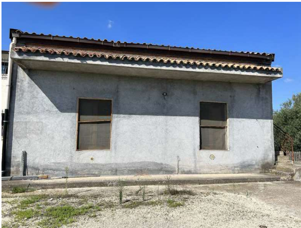
Foto 1: Contrada Macchiotta_prospetto sud-est
