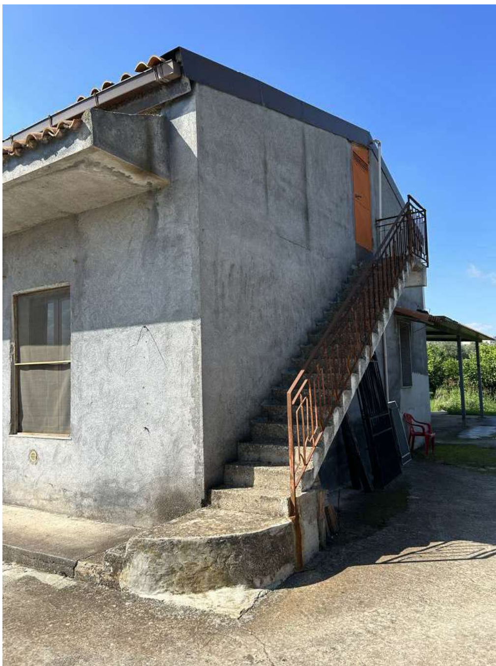
Foto 2: Contrada Macchiotta_prospetto est
