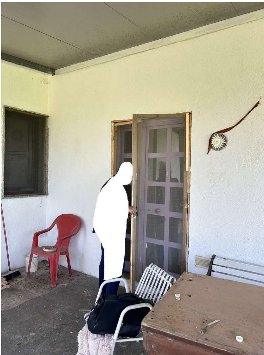
Foto 3: Contrada Macchiotta_prospetto nord-ovest-ingresso
