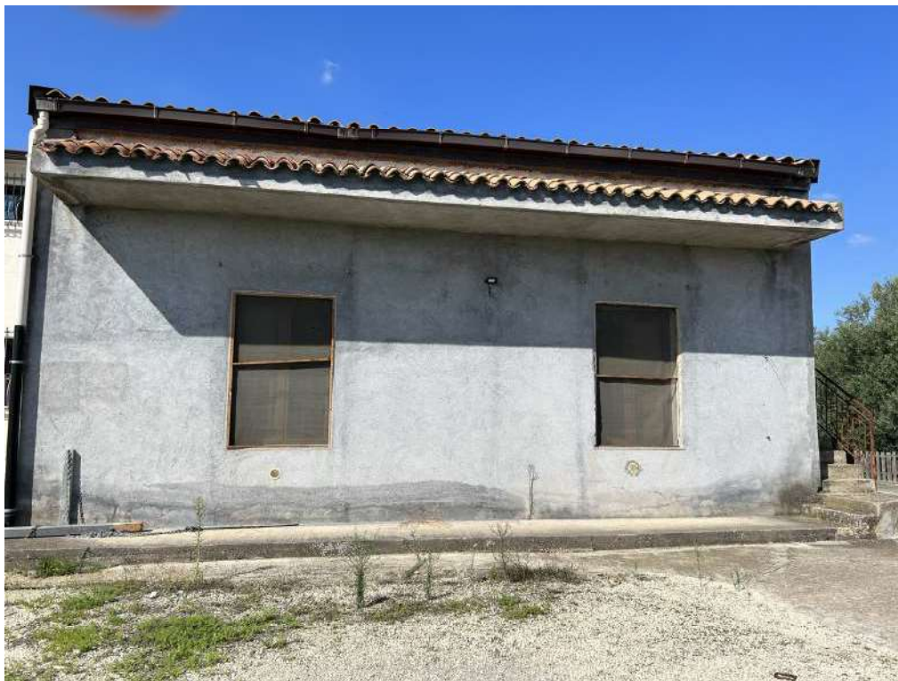
Foto 1: Contrada Macchiotta_prospetto sud-est
