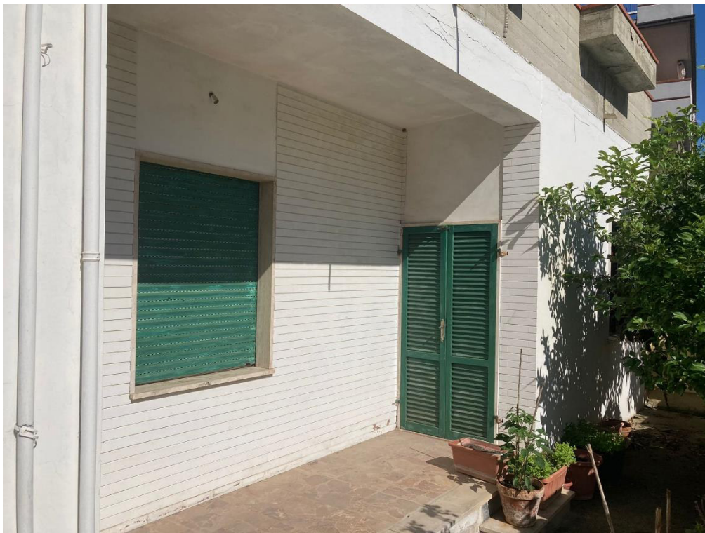
FOTO N 7 Ingresso unità lato est
