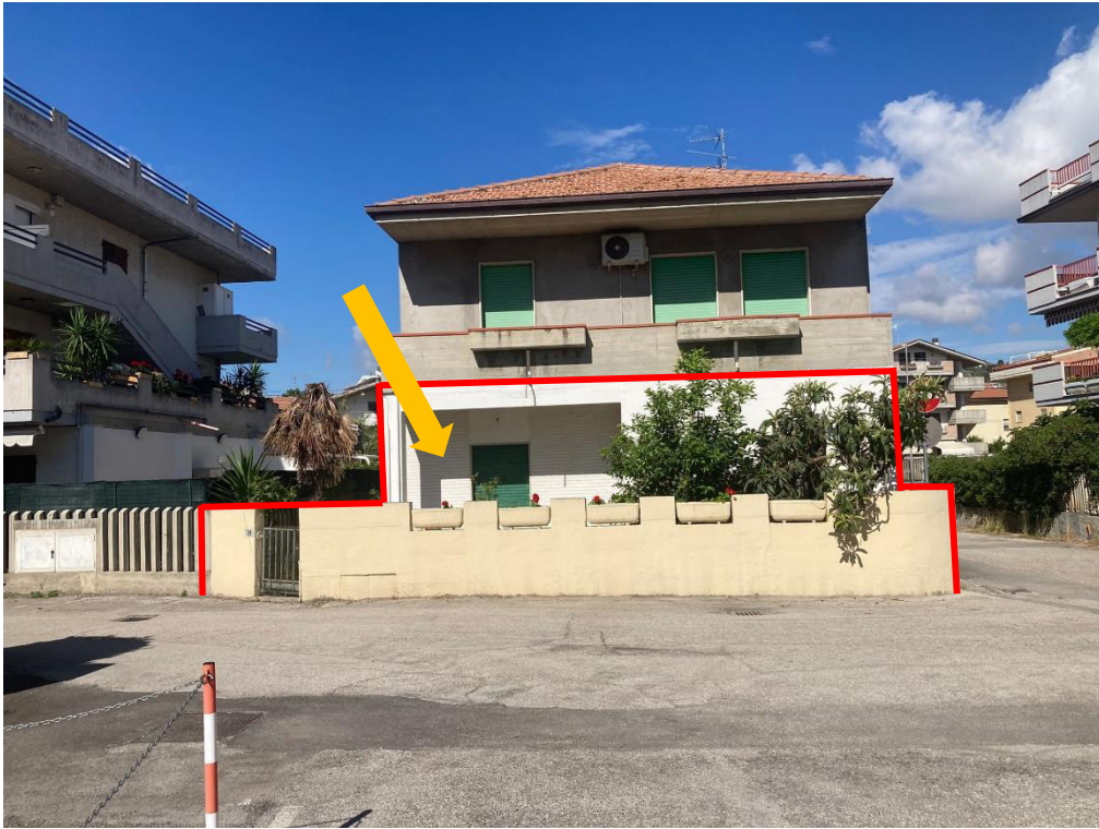
FOTO N 3 Lato Est
