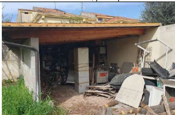
-Vista della tettoia nord-
