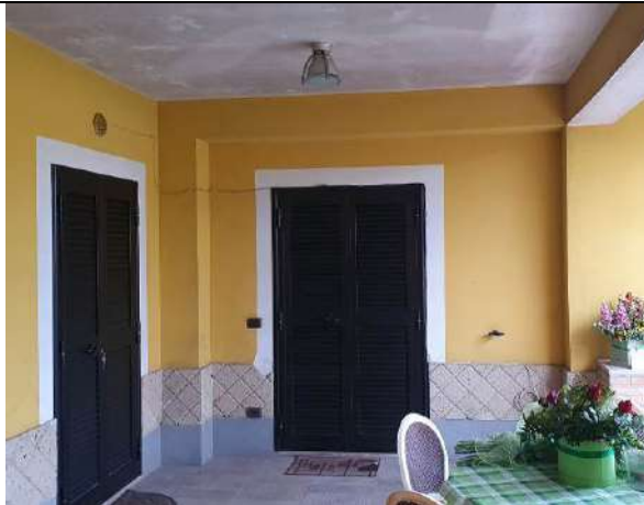
1 -Vista ingresso cucina (piano terra)-
