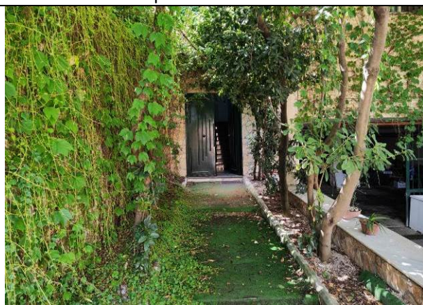
Accesso al vano scala dal cortile
