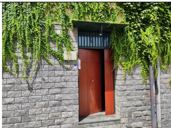
Accesso pedonale al vano scala
