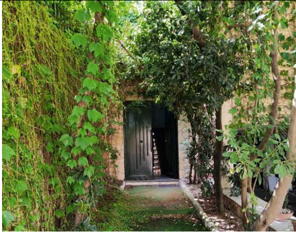
1 -Vista ingresso vano scala-
