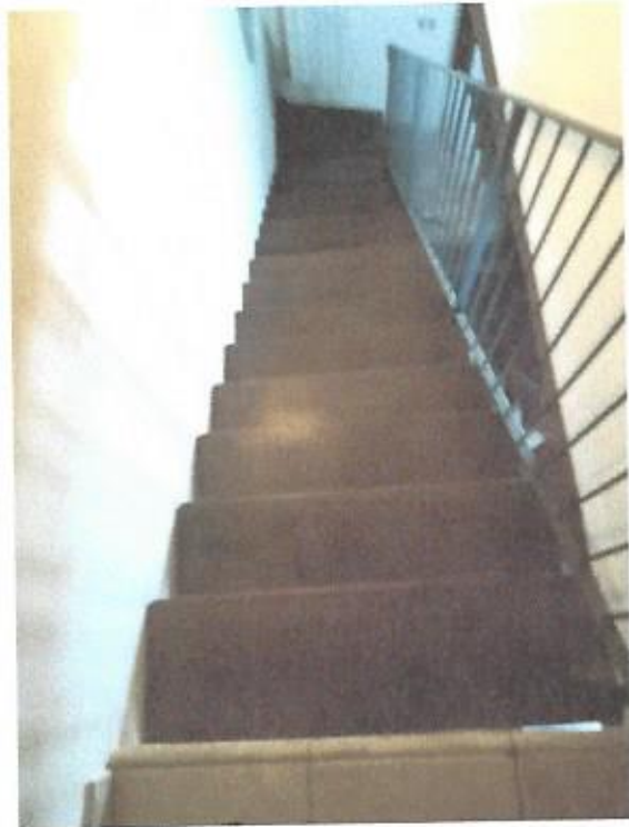
Fotografia E.9 - F.4- Rampa in profilato di ferro scatolare gradini in legno, collega la zona giorno al piano terra con la Taverna al piano S1
