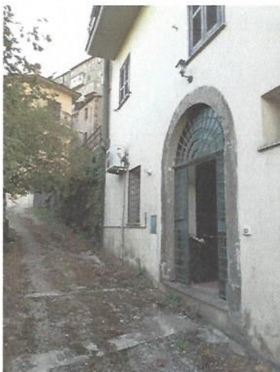
Fotografia E.4 - Foto n.4- Orientamento NORD
