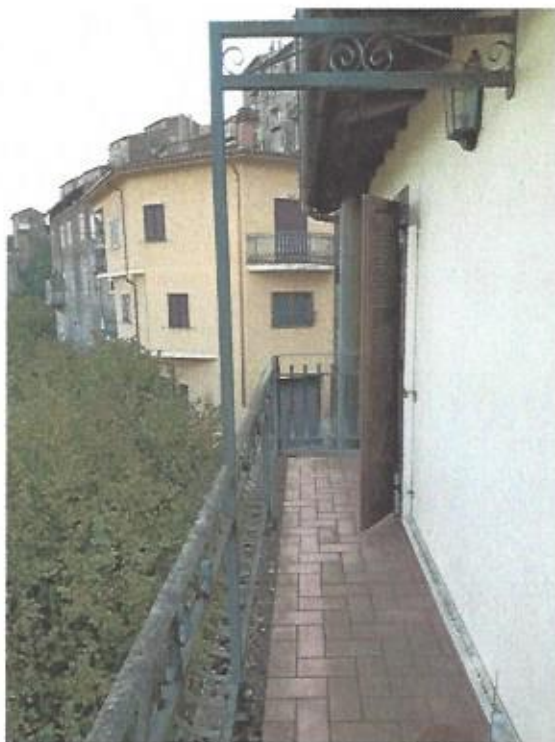
Fotografia E.19 - F.5- Balcone con vista su Valle Maggiore
