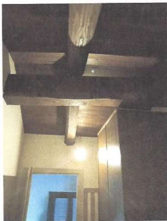
Fotografia E.16 - F.3- Particolarita' della struttura consistente del solaio in legno
