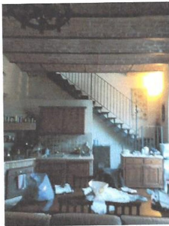
Fotografia E.6 - Foto 1 - stato attuale della Taverna - Piano S1
