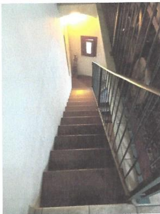
Fotografia E.14 - F.1- Rampa di scala in profilato di ferro scatolare ,gradini in legno comunica il Piano Terra con il Piano Primo
