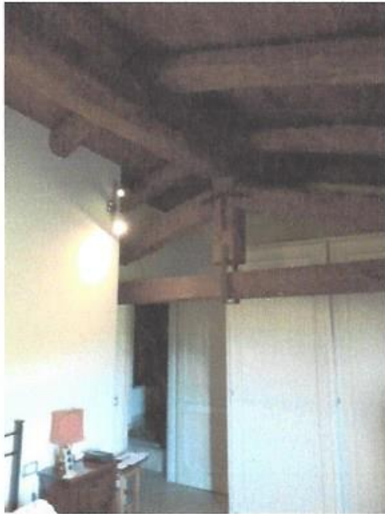
Fotografia E.17 - F.3a- Particolarita' del solaio in legno- capriata-
