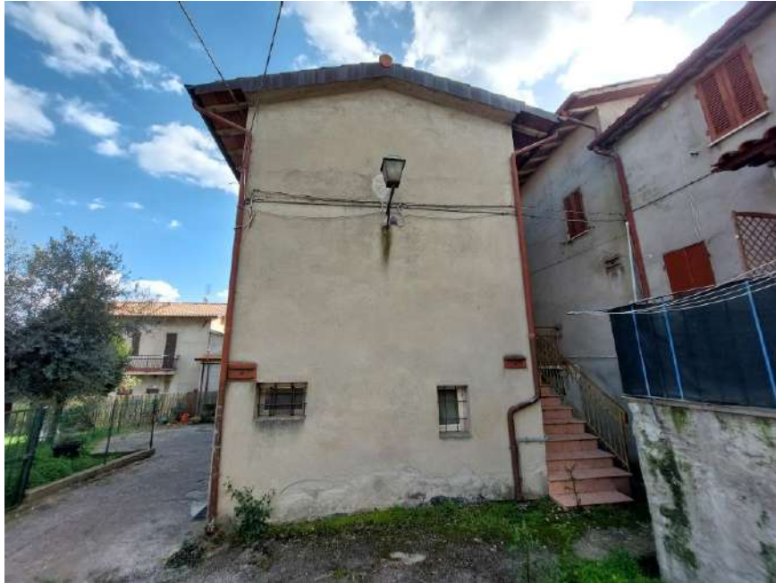
Foto n.3: Particolare del prospetto nord del fabbricato. Notare le tamponature esterne intonacate e non tinteggiate, il tetto del tipo a due falde con manto di copertura in coppo tegola e le finestre della cantina dotate d'infissi ed inferriata in metallo.
