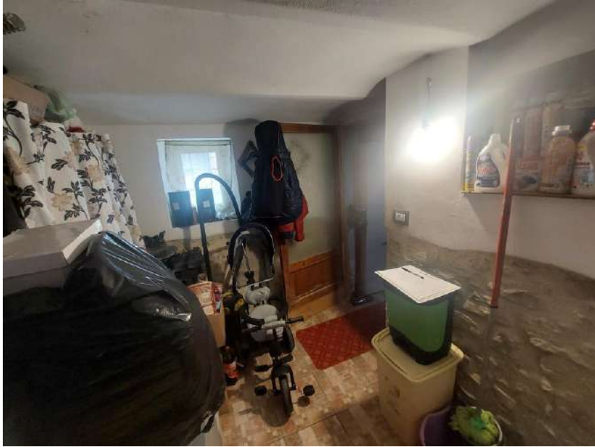
Foto n.9: Particolare della cantina al piano terra. Sono visibili il pavimento rivestito con piastrelle in monocottura, le pareti parzialmente intonacate e tinteggiate, l'impianto elettrico sotto traccia. Notare al centro dell'immagine la porta in legno vetrata che immette al vano scala.
