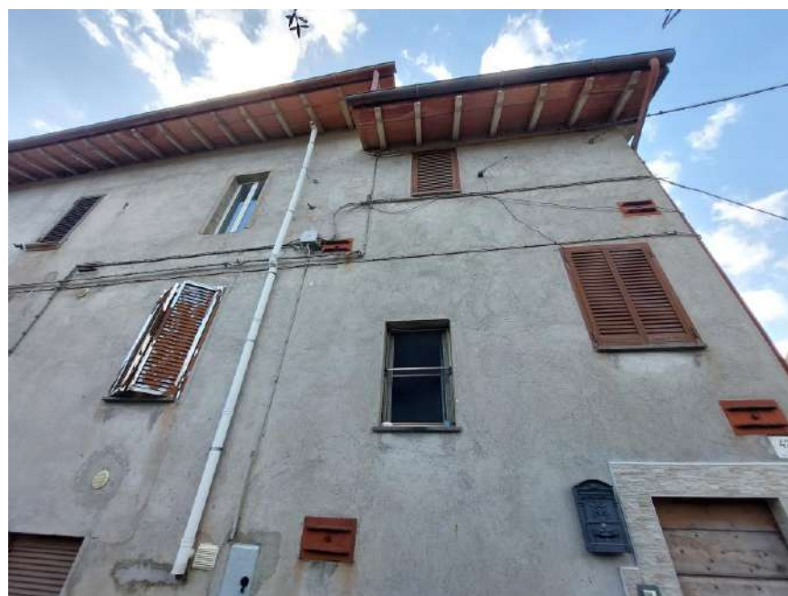
Foto n.2: Altro particolare del prospetto est del fabbricato. Notare le persiane in metallo.
