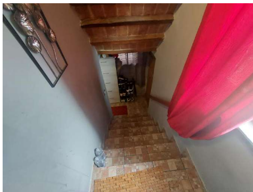
Foto n.8: Particolare dell'atrio al piano terra. Notare la scala di collegamento tra il piano terra e il primo rivestita in piastrelle in monocottura e il corrimano in legno.
