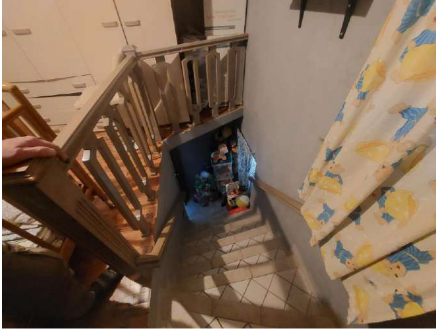
Foto n.17: Particolare della scala di collegamento tra il primo piano e il secondo piano ripresa dalla camera al secondo piano. Notare la scala rivestita in piastrelle in monocottura e il corrimano in legno.
