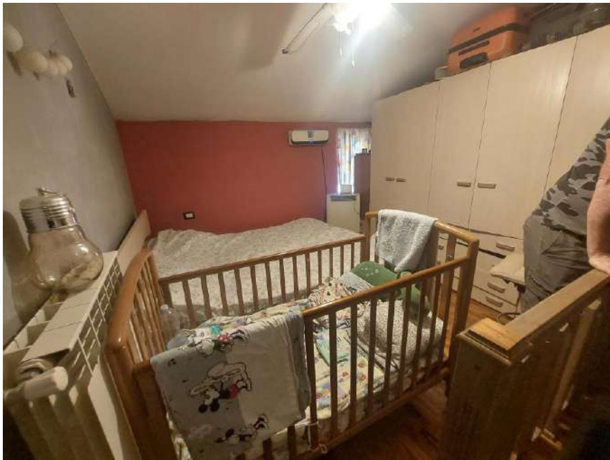
Foto n.18: Particolare della camera al secondo piano. Notare, le pareti intonacate e tinteggiate, l'impianto elettrico sottotraccia, il pavimento in parquet e in alto l'impianto di condizionamento.
