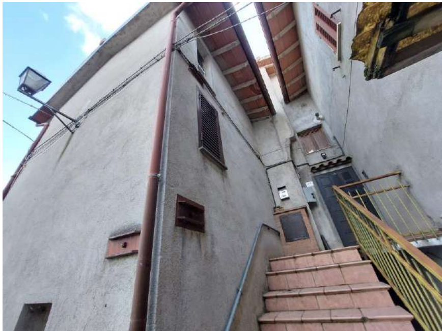
Foto n.4: Particolare dei prospetti nord ed ovest del fabbricato. Notare le persiane in metallo e i canali di gronda e i pluviali discendenti di lamiera zincata.
