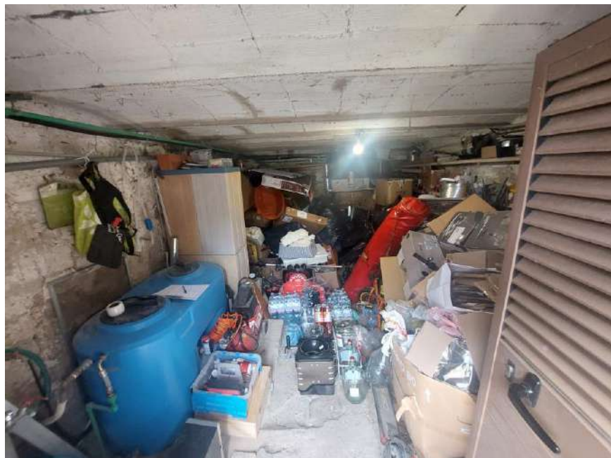
Foto n.6: Particolare interno della cantina al piano terra. Notare le pareti al grezzo, pavimentato in battuto di cemento e l'impianto elettrico fuori traccia.
