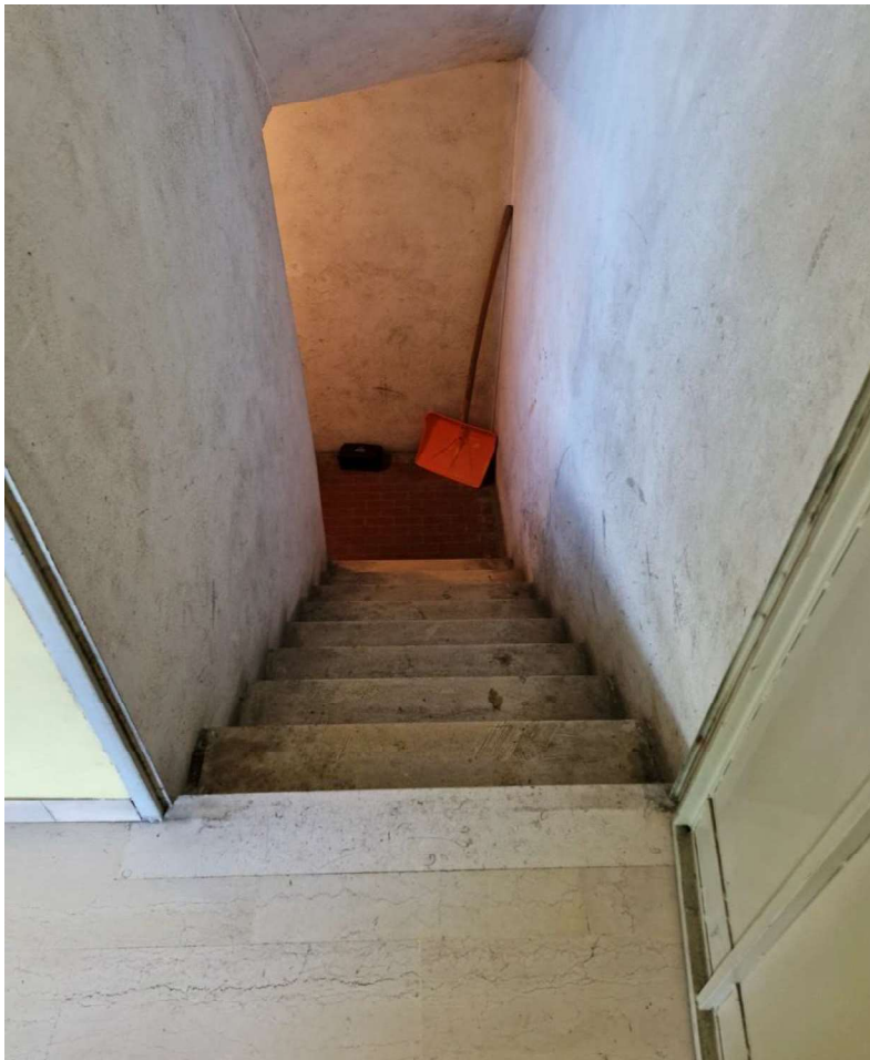
FOTO 8 – Scala di accesso alla cantina
