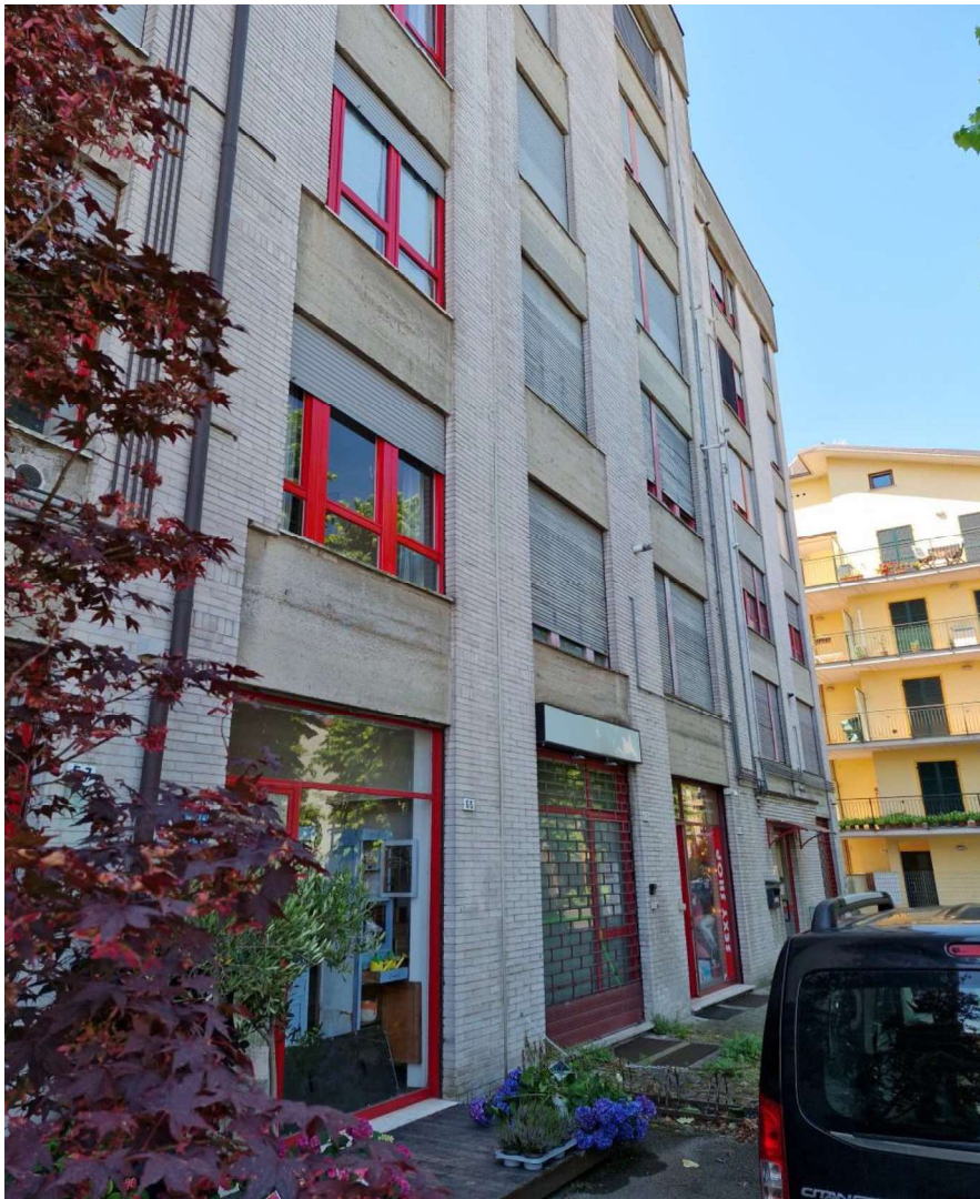
FOTO 1 – Vista condominio da Via Arzani
