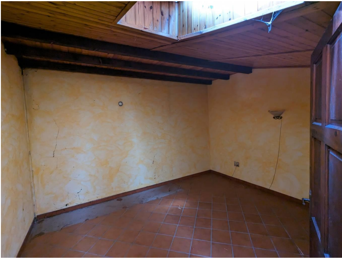
Immagine 15 - P.2 Soffitta n.2
