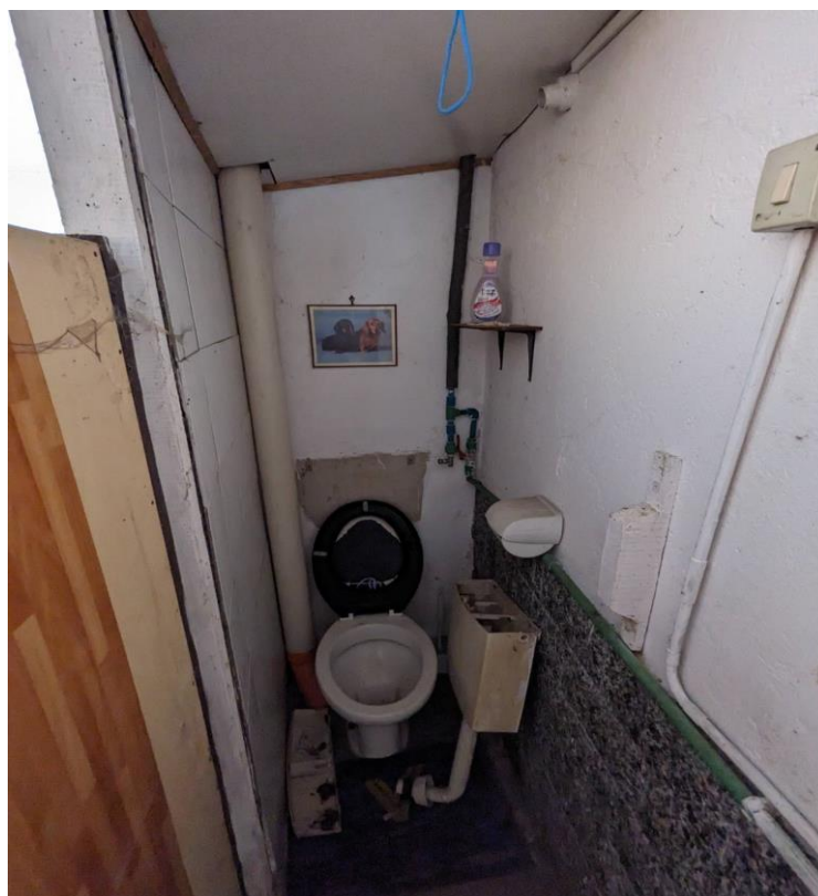
Immagine 20 - servizio igienico nel ripostiglio (sub. 4)
