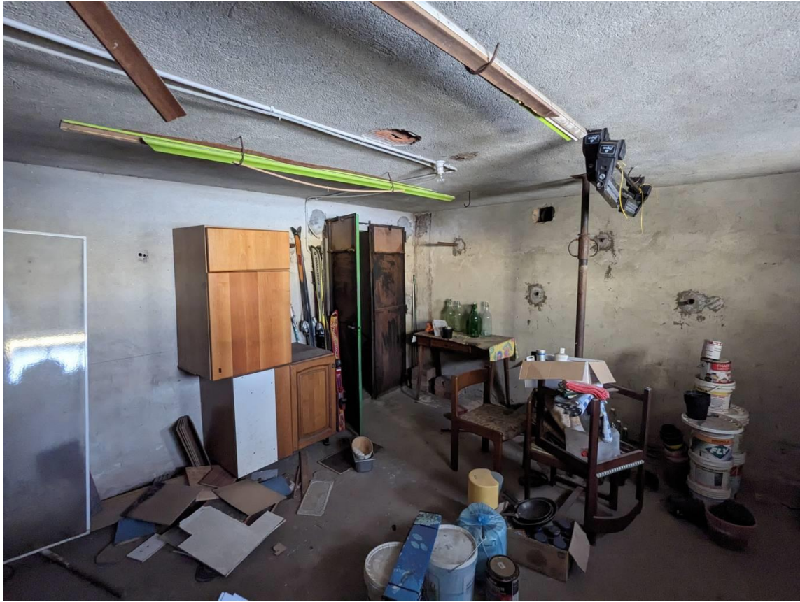
Immagine 3 - P-1 Locale Cantina
