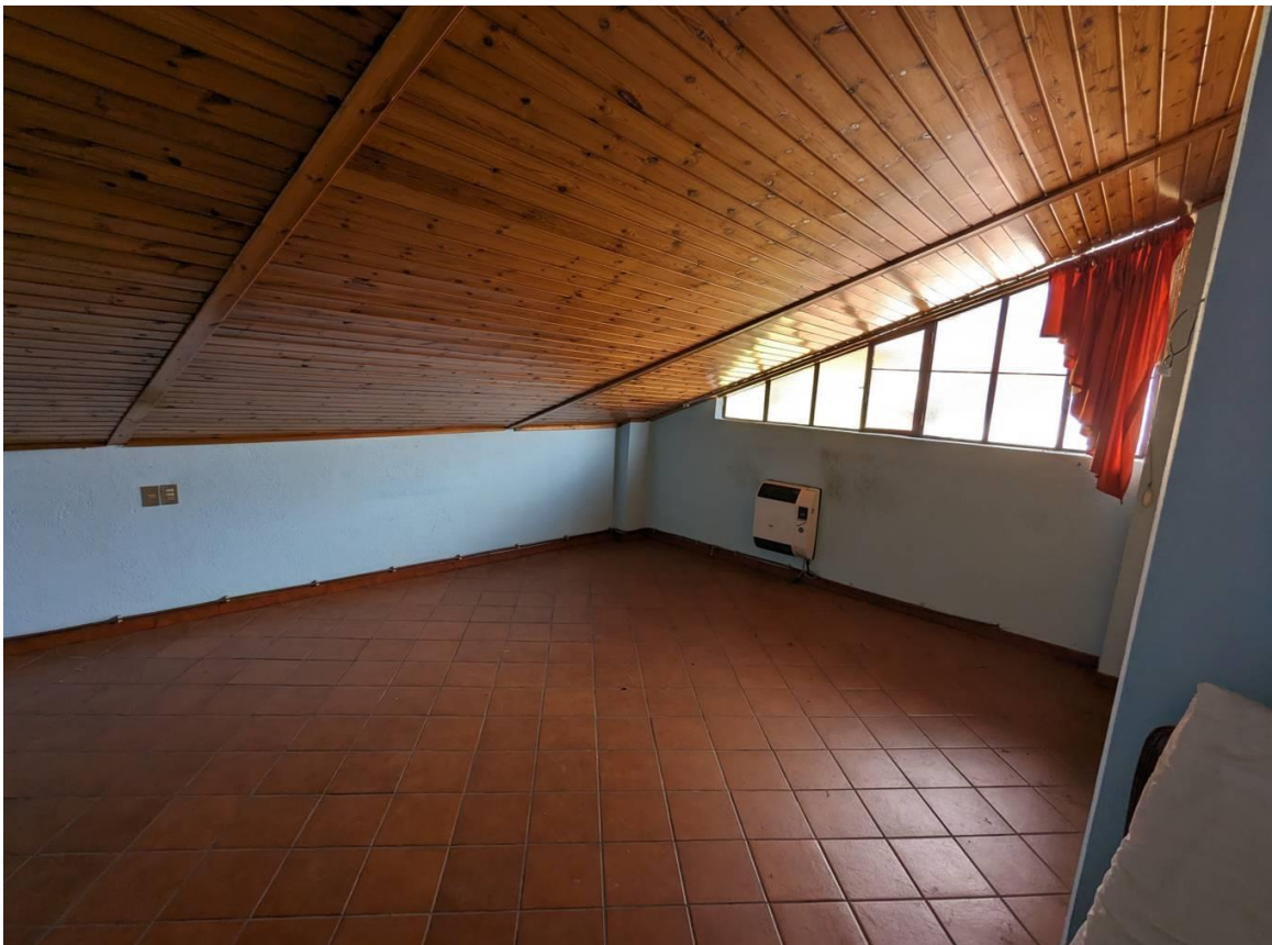
Immagine 14 - P.2 Soffitta n.1
