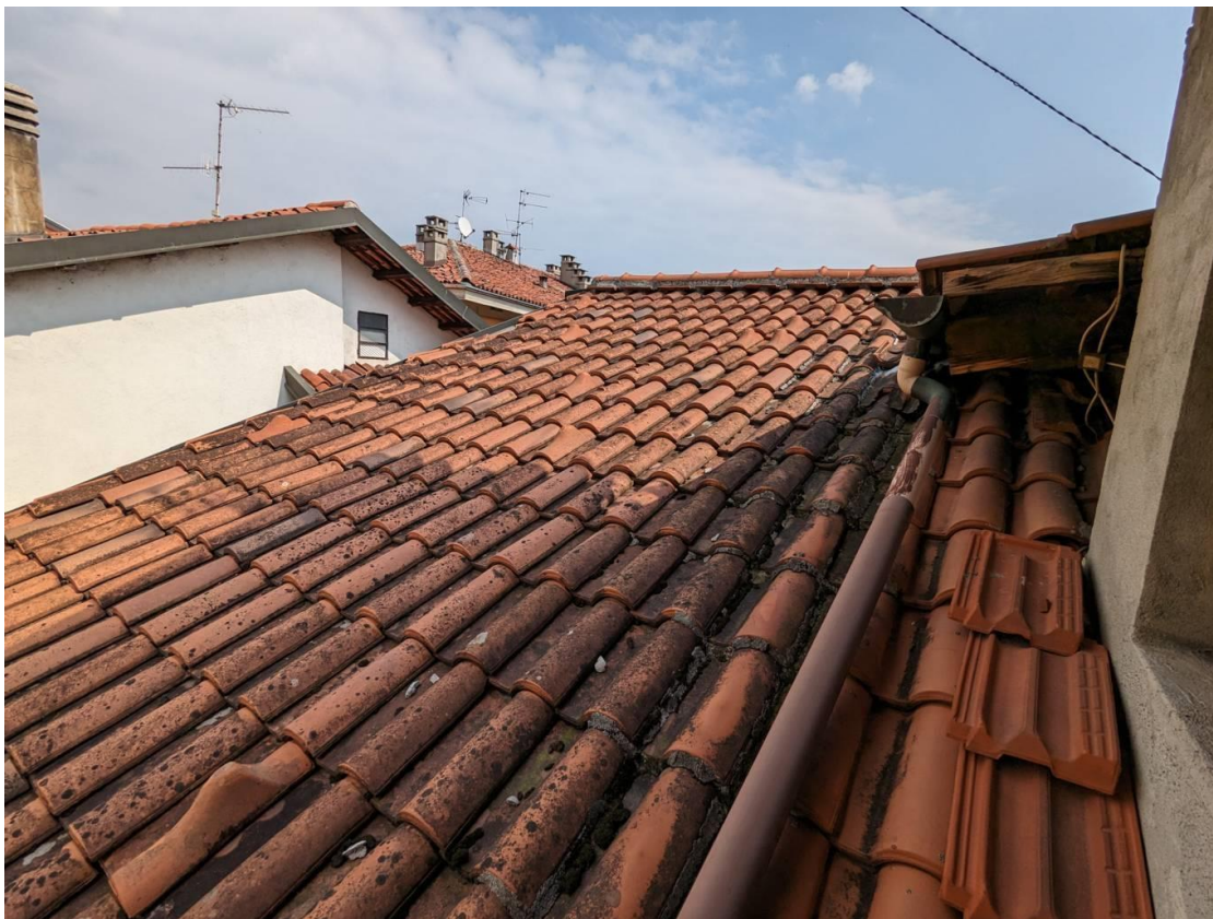
Immagine 18 - P.2 Particolare del manto in coppi
