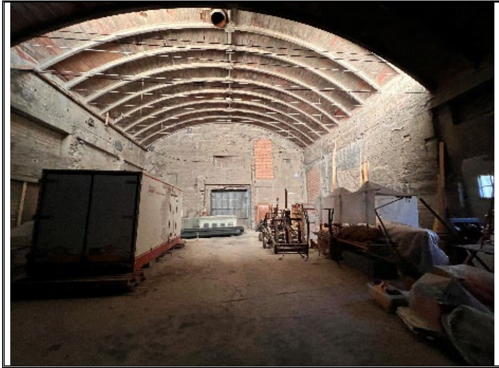
FOTO Nr. 11 – interno opificio
