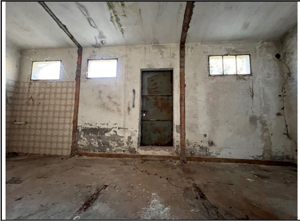
FOTO Nr. 13 – interno opificio
