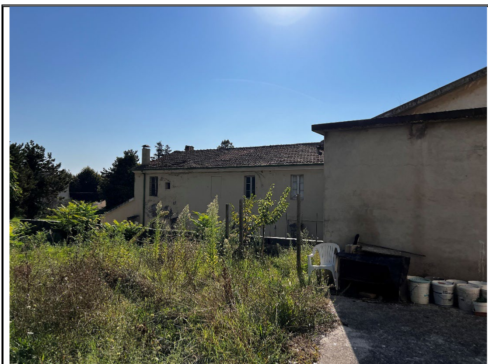
FOTO Nr. 04 – retro palazzina uffici
