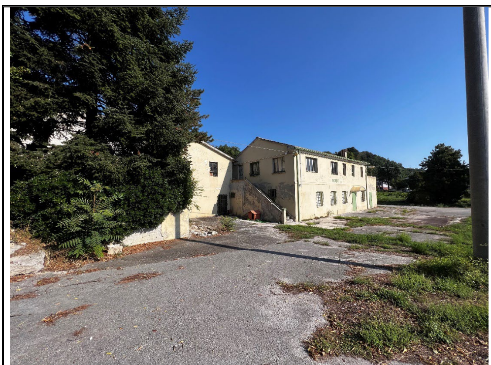
FOTO Nr. 06 – fronte e fianco sinistro palazzina uffici
