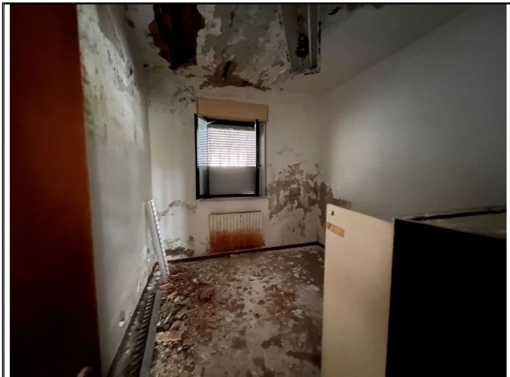
FOTO Nr. 14 – interno palazzina uffici
