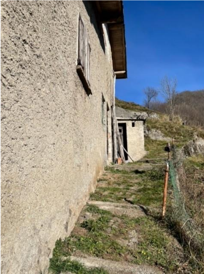
Figura 13 Edificio rurale ed ex abitazione (lato e servizi igienici esterni)
