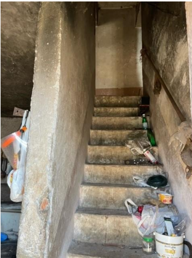
Figura 16 Edificio rurale ed ex abitazione (scala interna accesso a primo piano)
