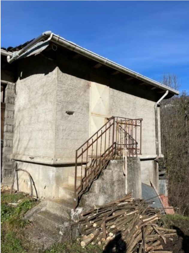
Figura 2 Stalla con fienile - Esterno (lato)
