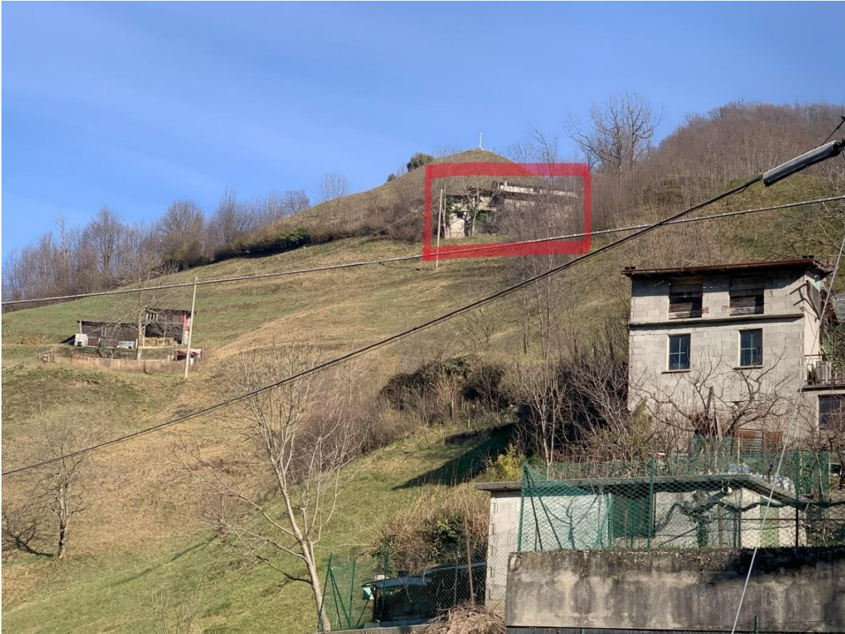
Figura 17 Edificio rurale ed ex abitazione (vista dal parcheggio dove termina la strada carrabile)
