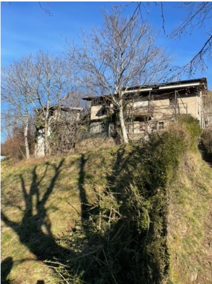
Figura 9 Edificio rurale ed ex abitazione
