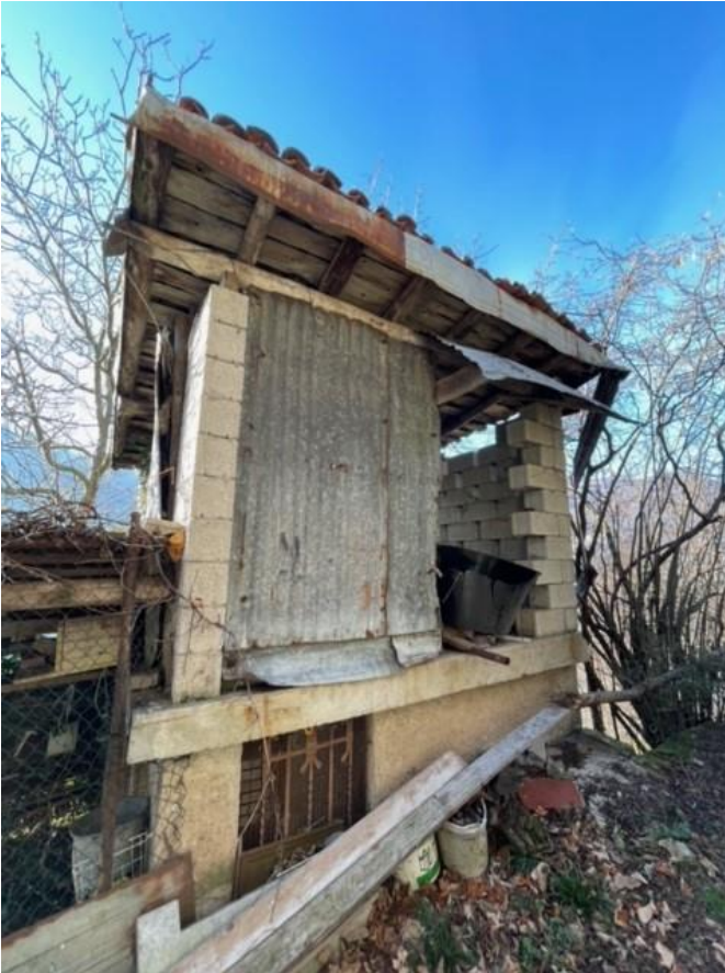
Figura 12 Edificio rurale ed ex abitazione (ex pollaio)
