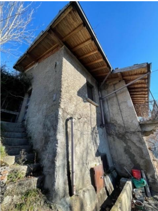
Figura 11 Edificio rurale ed ex abitazione (lato)
