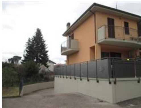
vista esterna fabbricato
