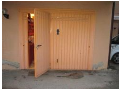
vista ingresso garage
