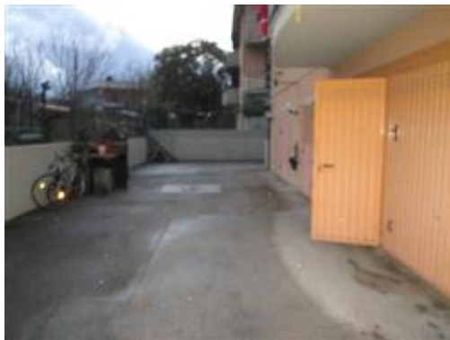
vista esterna fabbricato
