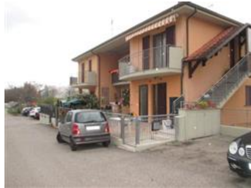
vista esterna fabbricato
