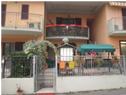
vista ingresso unità immobiliare
