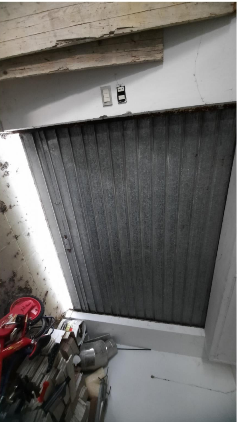
foto 18 - Serranda di ingresso garage al piano secondo sotto-strada
