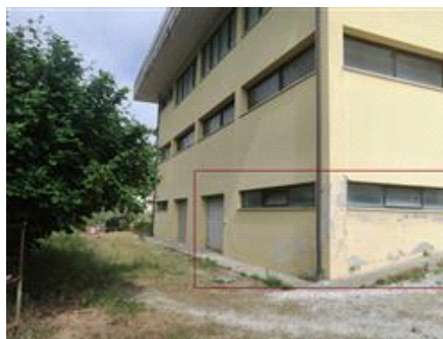
Garage al piano secondo sotto-strada
