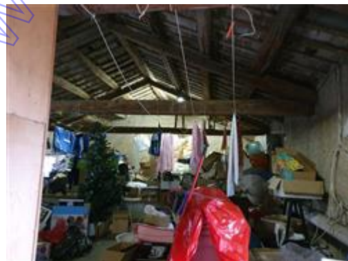
soffitta secondo piano
