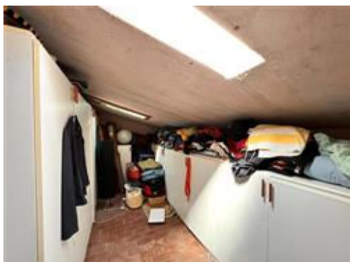
Depositi locali sottotetto
