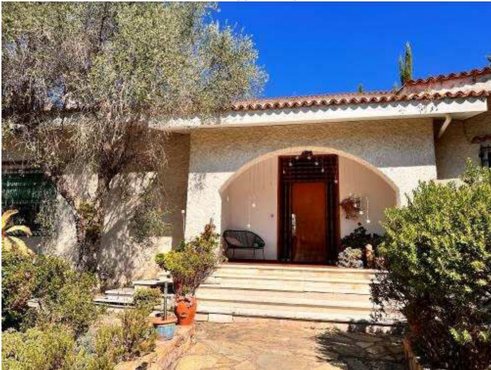
LOTTO 1 – CORPO B - Vista esterna portico e loggia di ingresso comuni
