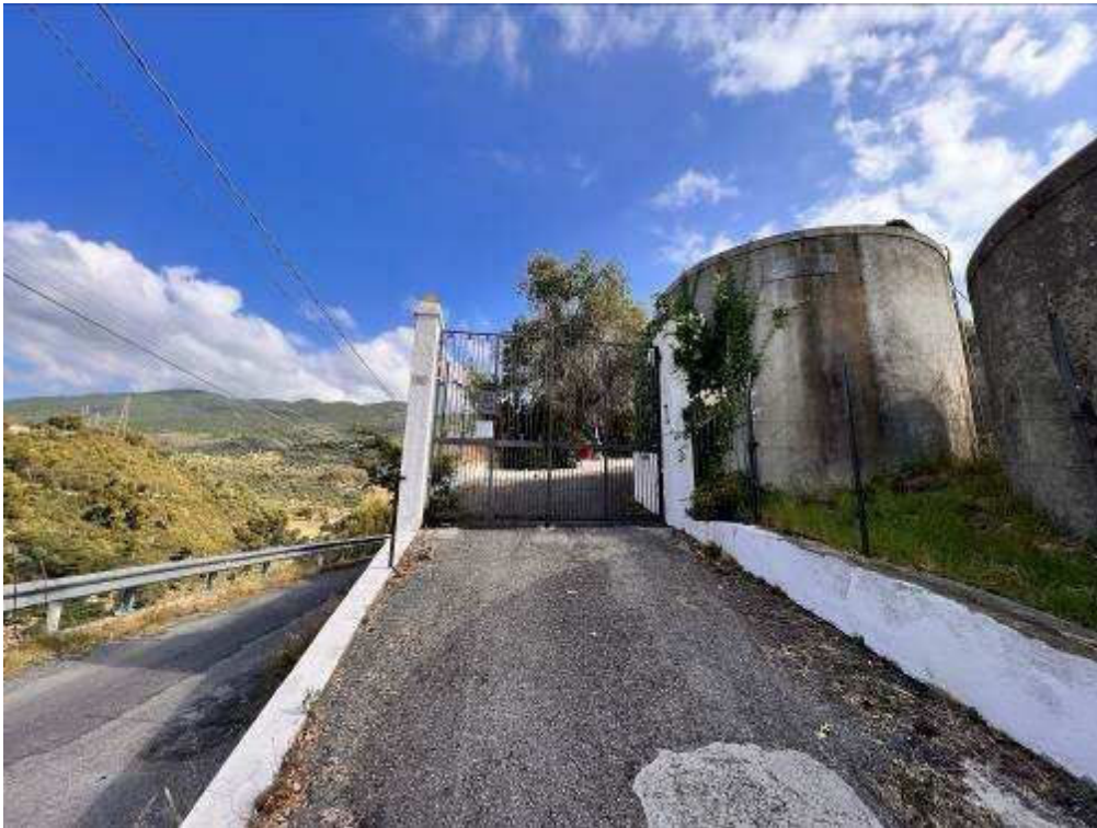
LOTTO 1 - CORPO D - Vista esterna
