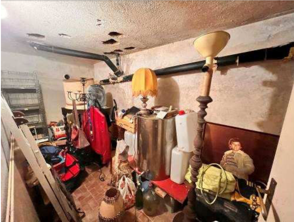
LOTTO 1 – CORPO B - Vista interna cantina al piano seminterrato
