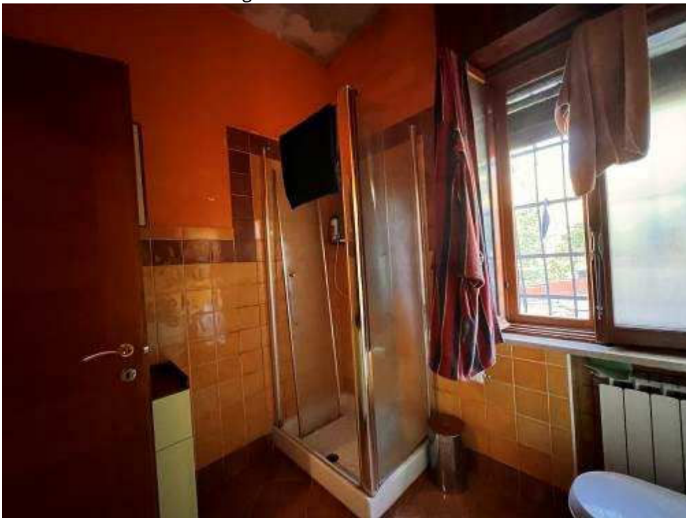
LOTTO 1 – CORPO B - Vista interna bagno
