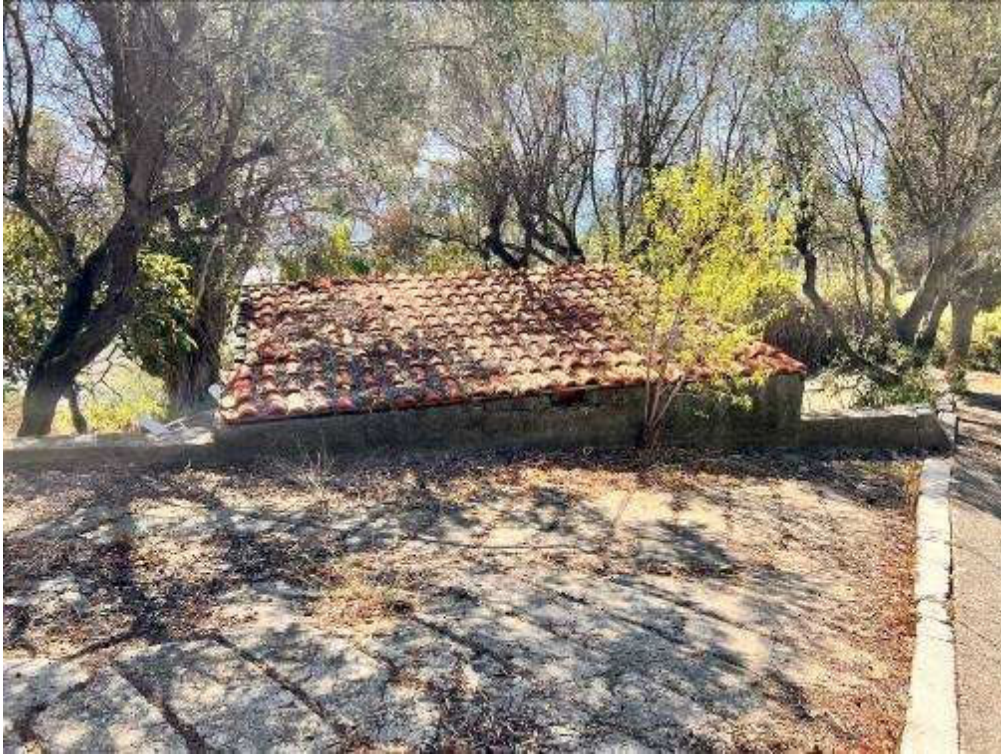
LOTTO 1 - CORPO D - Vista esterna
