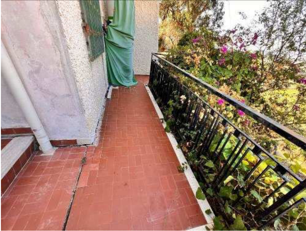
LOTTO 1 – CORPO B - Vista esterna camminamento
