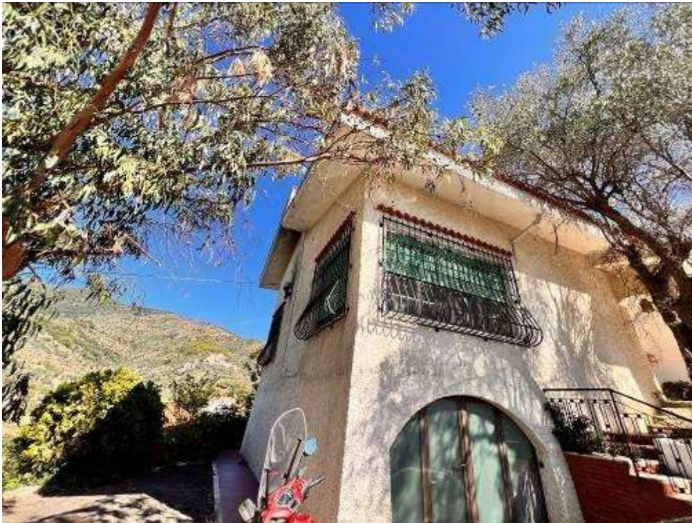
LOTTO 1 – CORPO B - Vista esterna
