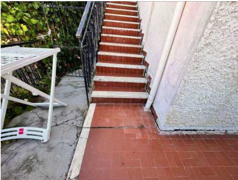
LOTTO 1 – CORPO B - Vista esterna scala e camminamento
