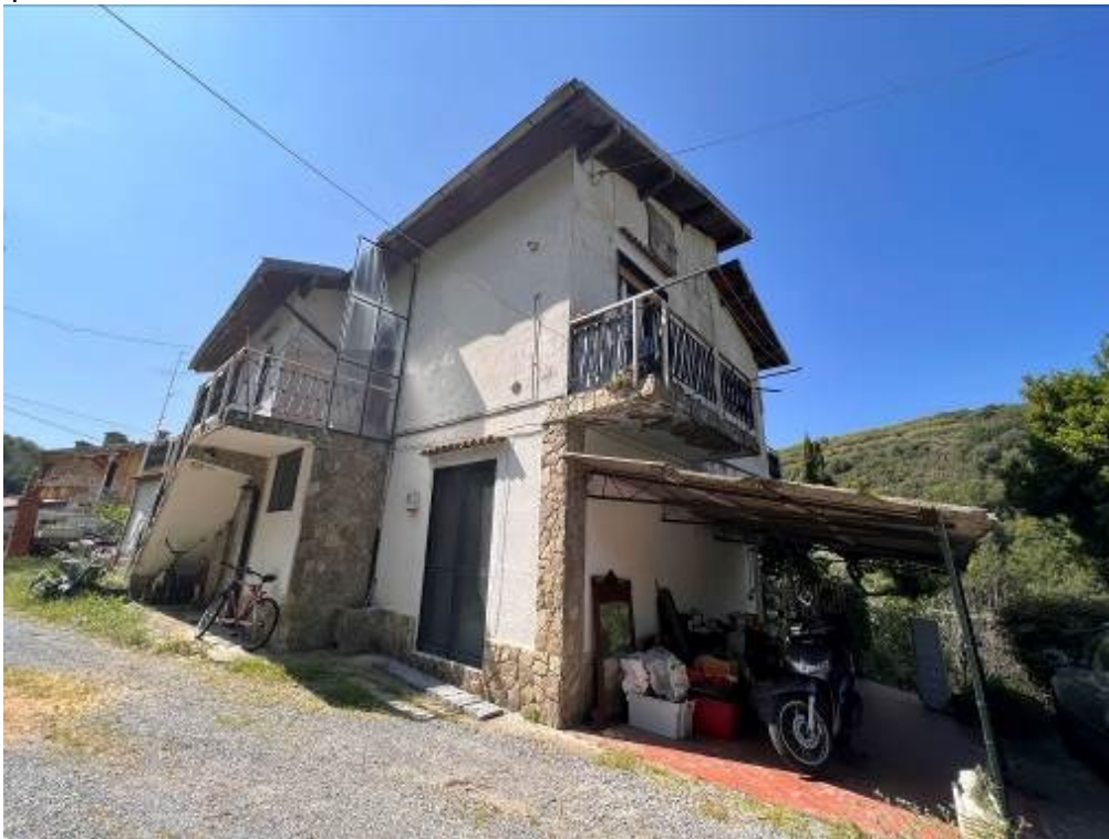
Lotto 1 Corpo B – Vista esterna tettoia
