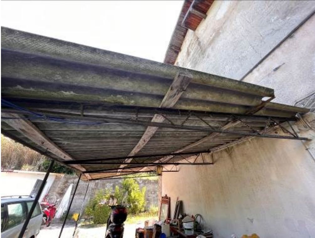
Lotto 1 Corpo B – Vista tettoia
