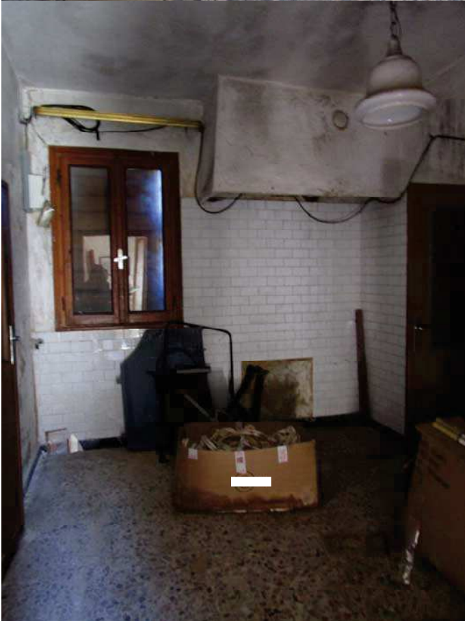
Foto 6 – Vista della cucina Lotto 1
