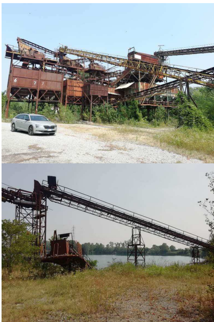
Impianto di estrazione
