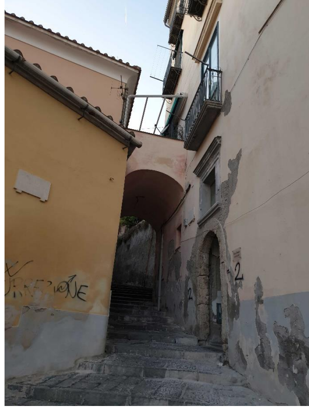
Immagine 29 vista del prospetto di ingresso
