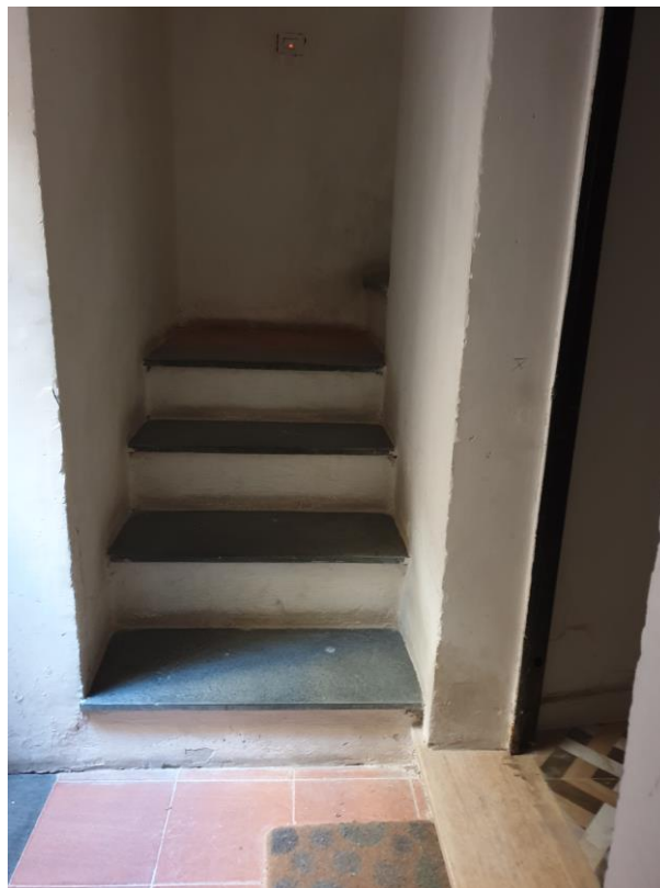
Immagine 11 porta di ingresso e scala condominiale
