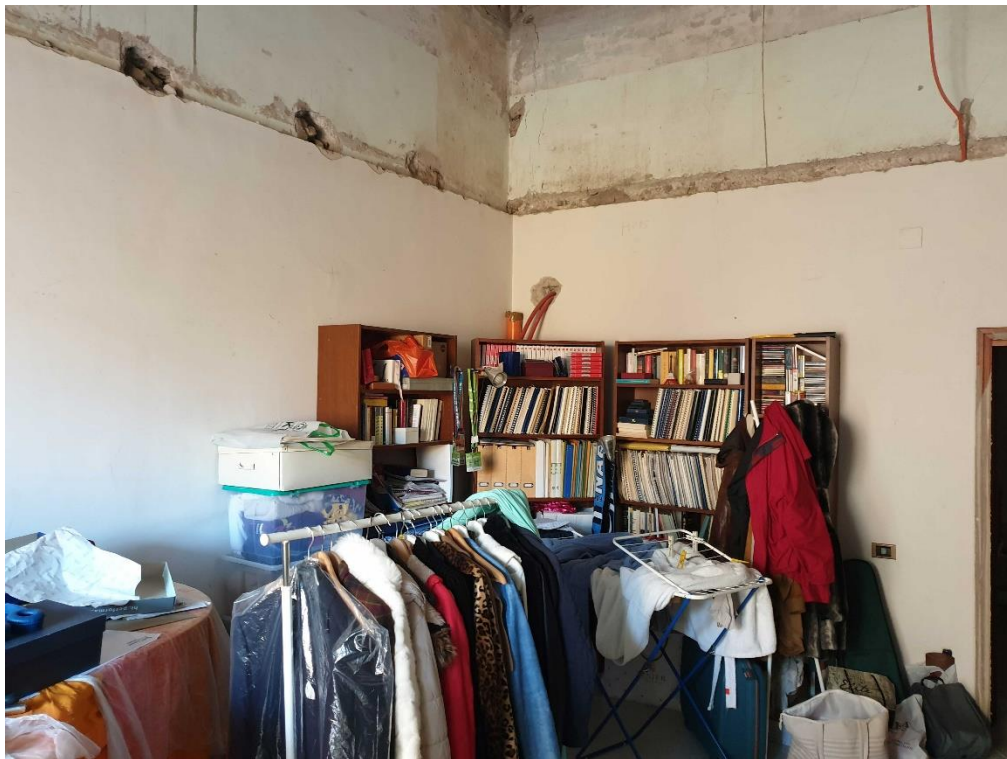
Immagine 23 Interno: vista dello studio (particolare delle finiture ed impianti)
