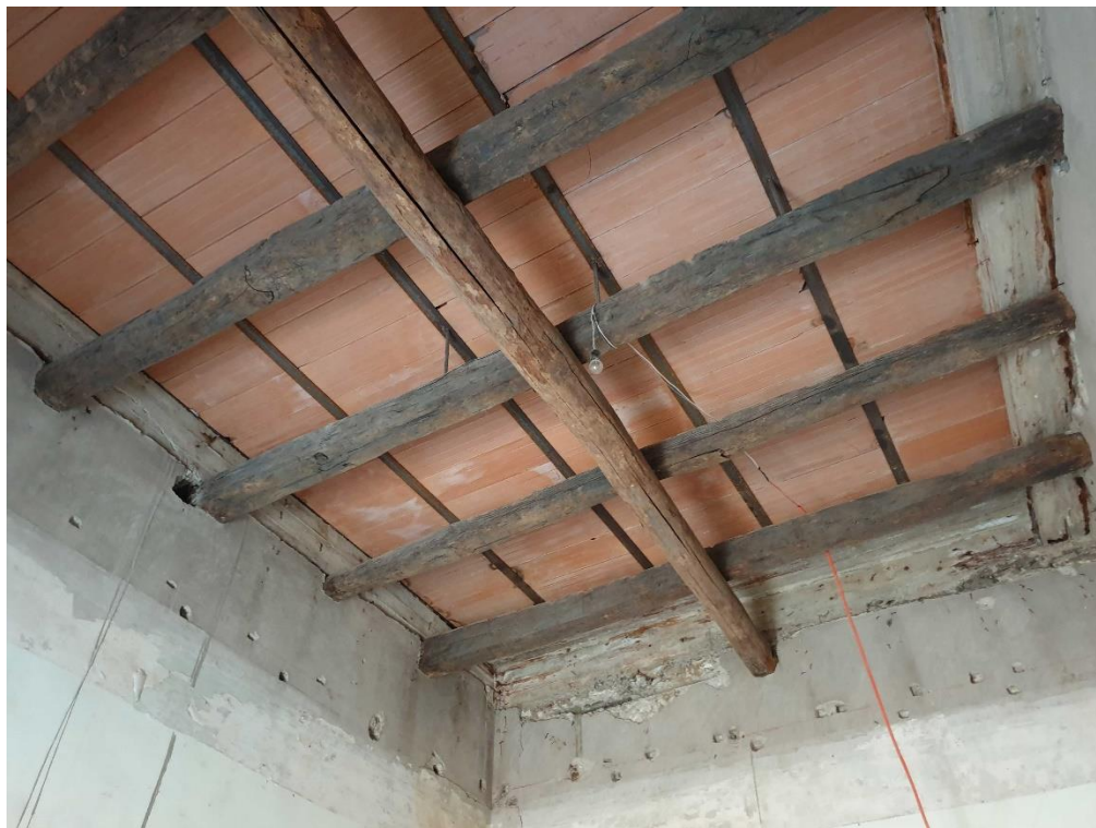
Immagine 24 Interno: vista dello studio (particolare del solio di copertura)
