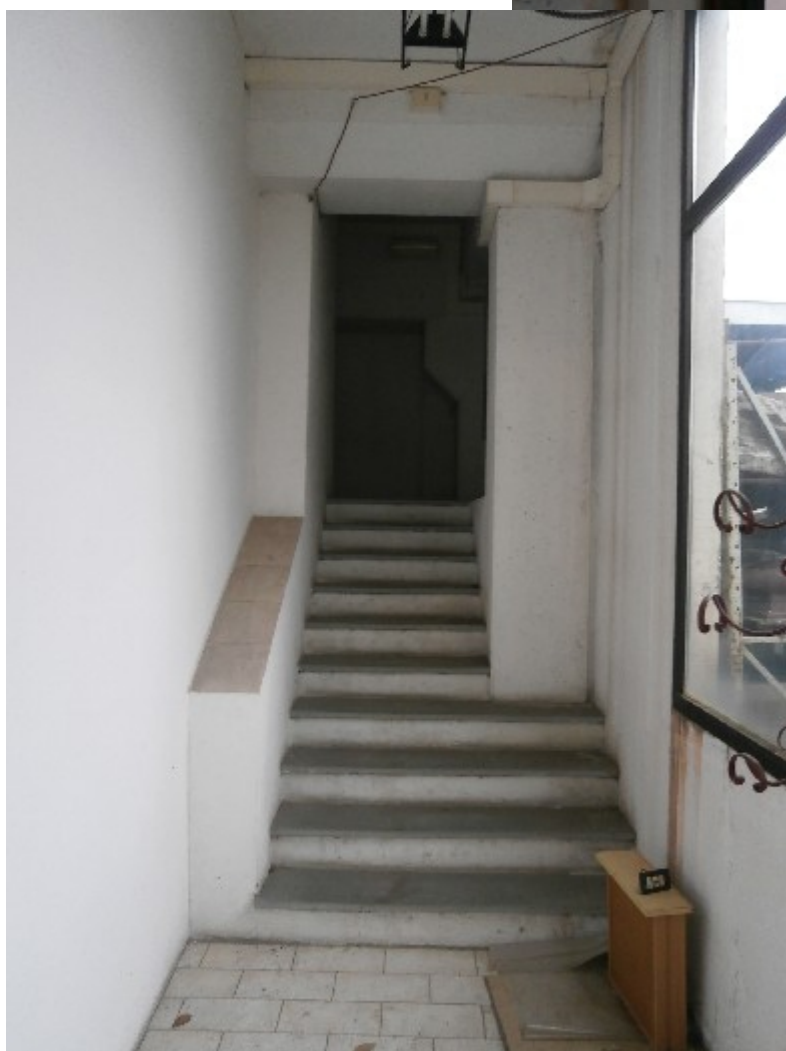
Foto 4: Scala, privata, di collegamento del piano terra all'ufficio, posto al piano primo
