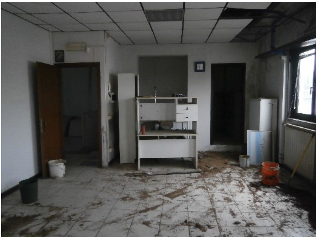
Foto 14: Vista vano 2 con vista Rip. 1 e Rip 2
