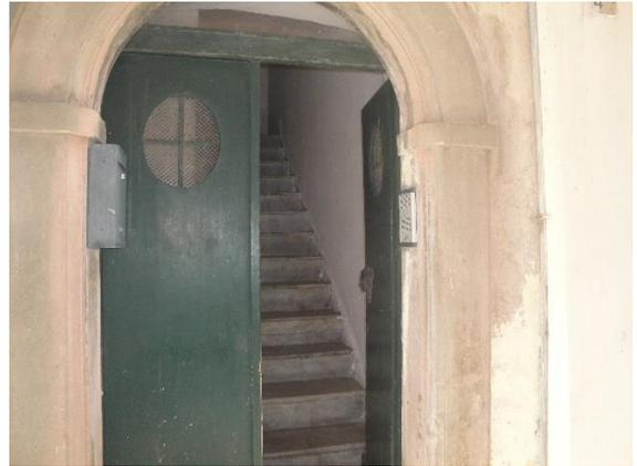
L'appartamento occupa gli ultimi tre livelli del suddetto fabbricato e si raggiunge attraverso tre rampe di scale, di cui le prime due rivestite in lastre di marmo e la terza con struttura in ferro e rifinita in legno, quest'ultima consente l'accesso all'appartamento pignorato.
