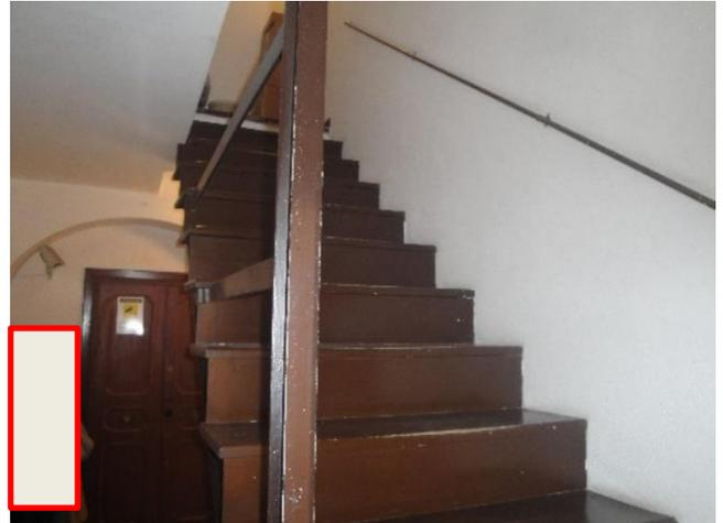
Tutto il corpo scala condominiale internamente versa in uno stato di abbandono, sono evidenti segni di infiltrazioni di acque meteoriche, gli infissi di vecchia fattura, sono in legno dotati di scuri, il tutto denota la vetustà degli anni e la mancanza di manutenzione. Le condizioni generali del corpo scala non sono buone.
