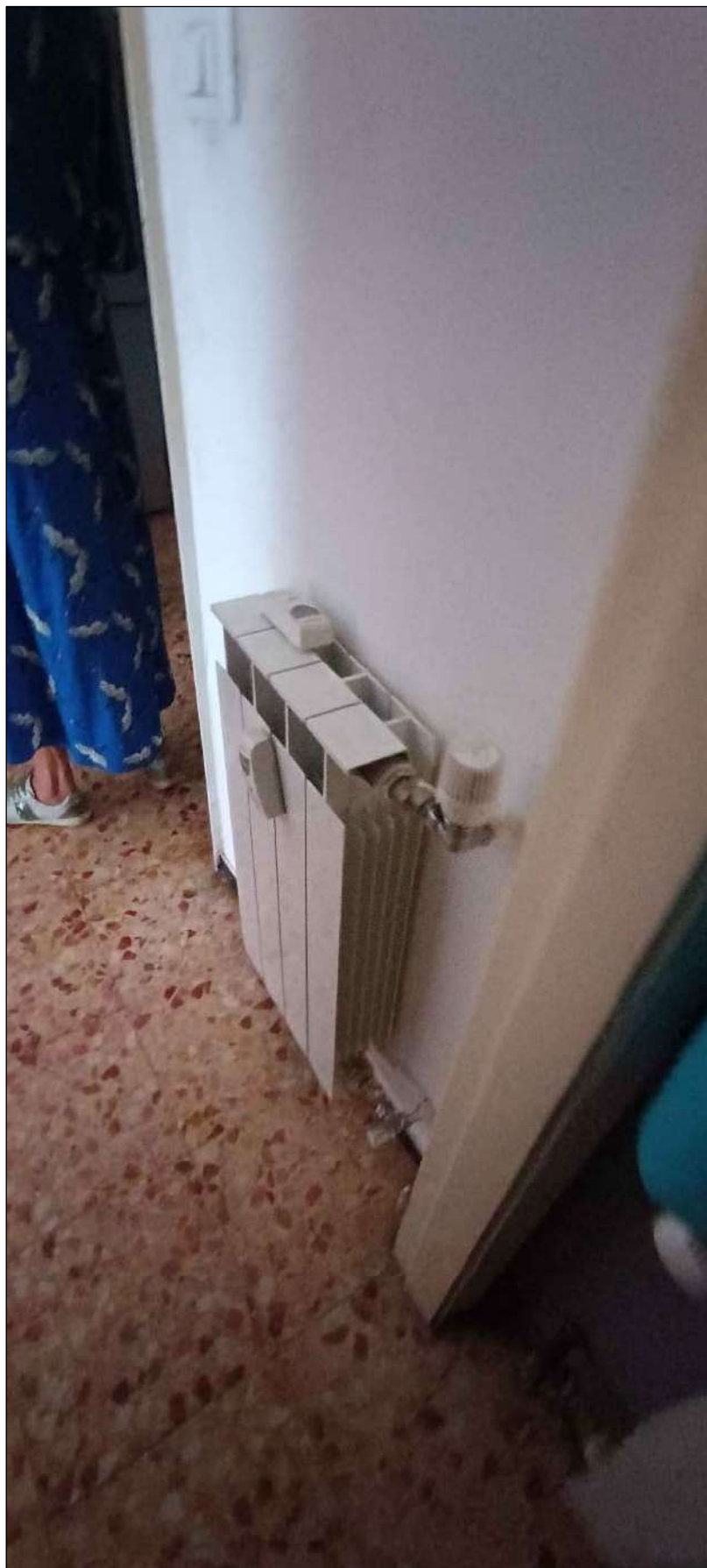
Foto 11 - dettaglio termosifone soggiorno
