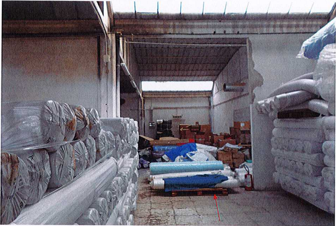
Accesso al sub. 19 dal sub. 14
