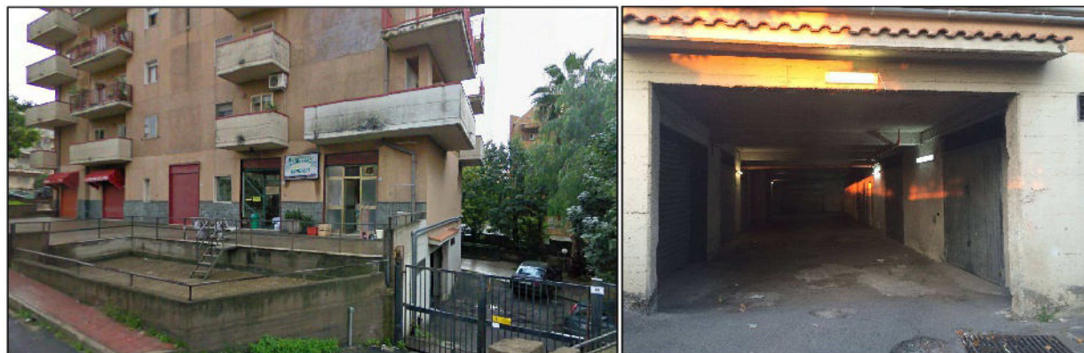
Figura 3: stabile condominiale su via De Gasperi con evidenza del passo carrabile che conduce al garage
