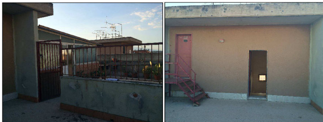
Figura 15: porta vano scala e terrazzo
