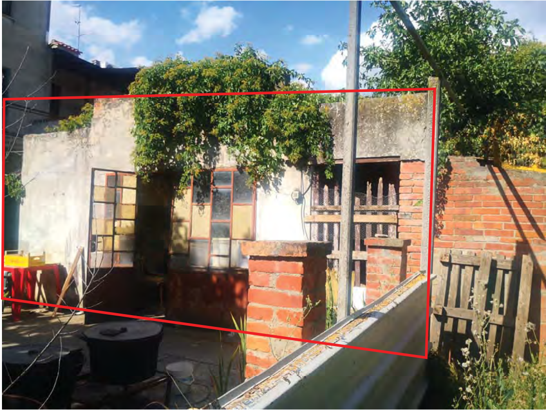
FOTO 42 - Autorimessa e tettoia
