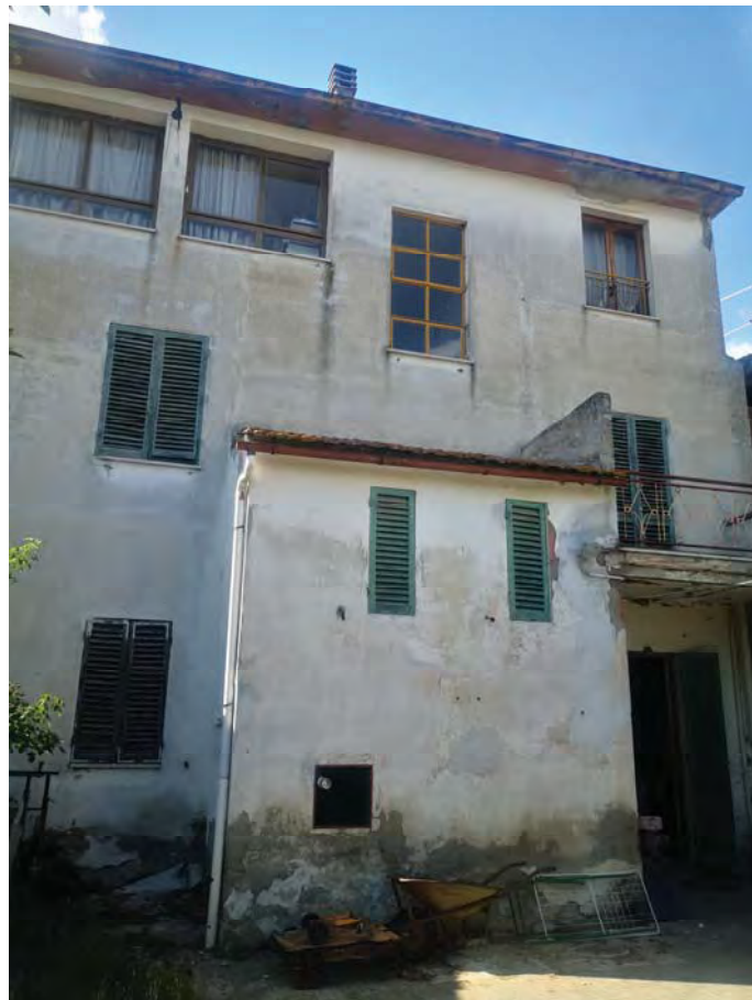
FOTO 47 - Viste retro da resede a comune con lotto 2
