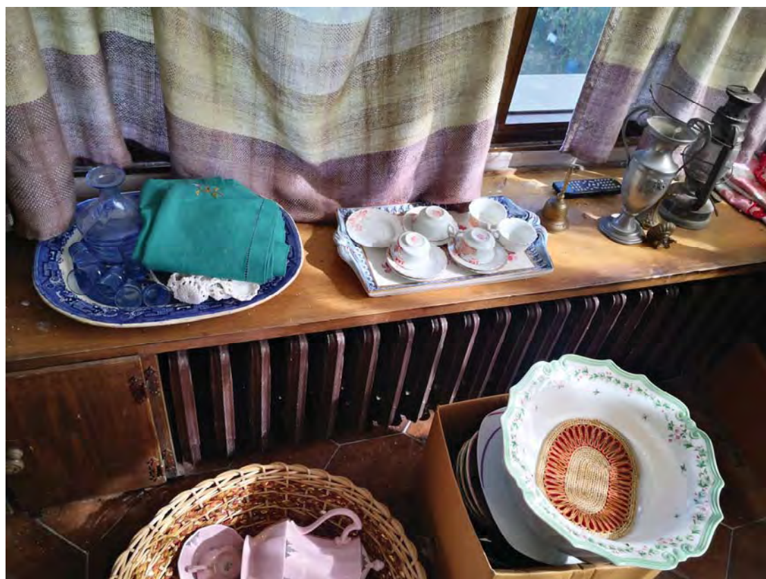
FOTO 29 - particolare elementi radianti p. secondo
