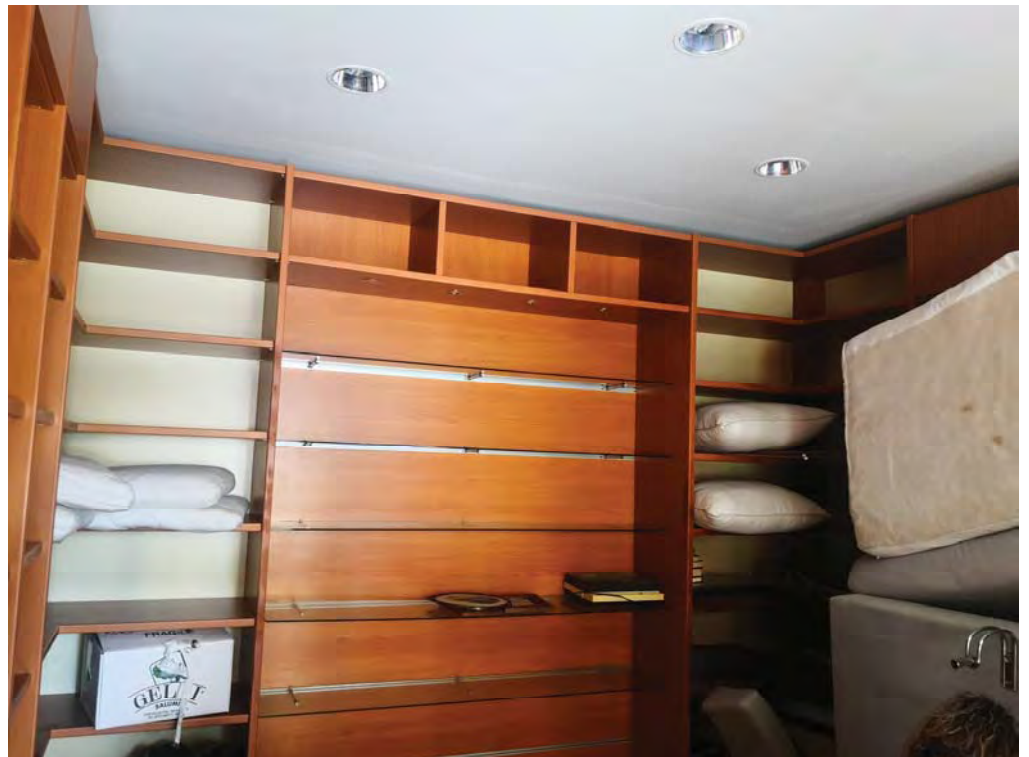
FOTO 3 parete di fondo/controsoffitto
