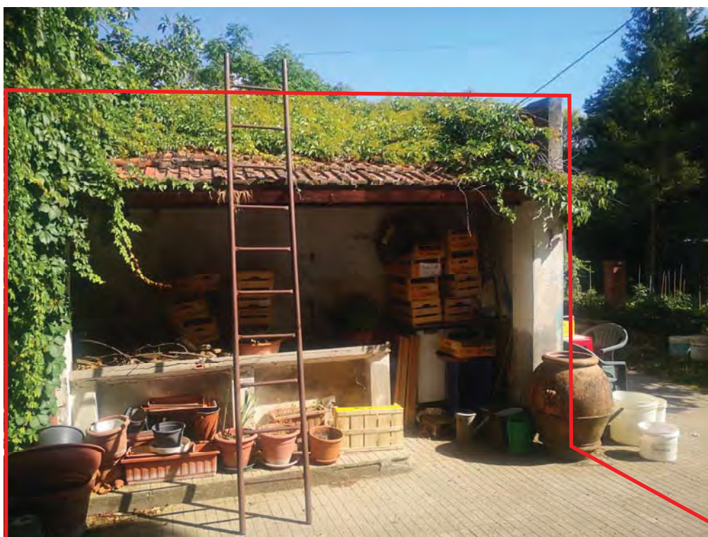
FOTO 13 - lavatoio e resede esclusivo
