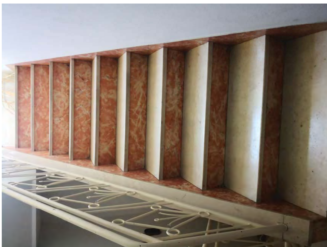
FOTO 18 e 19 - scala collegamento tra piano terra e primo
