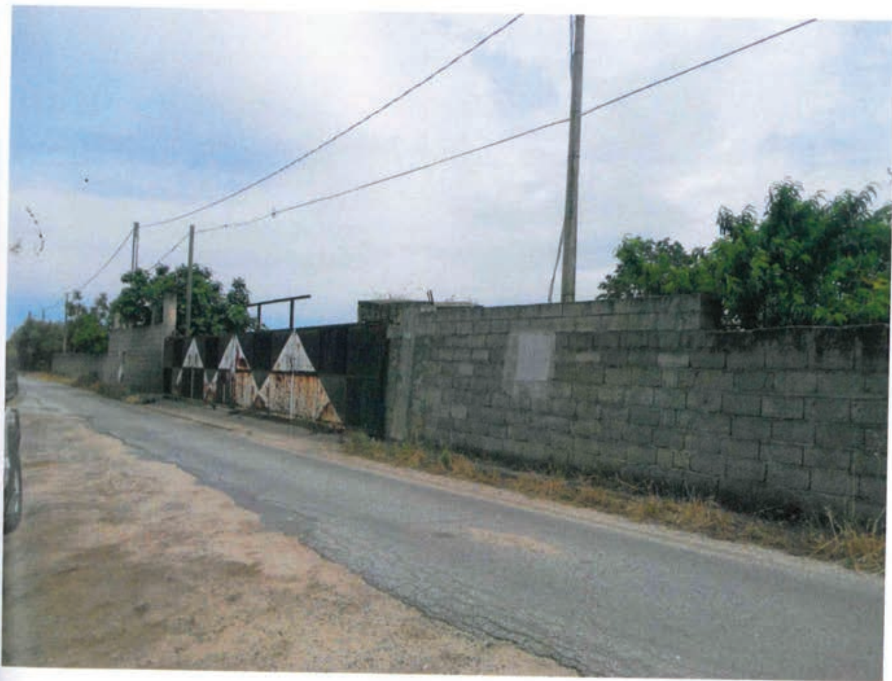
Muro recinzione lato ingresso strada IV stradone
