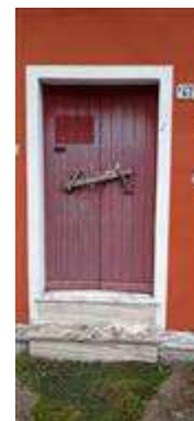
Portone d'ingresso al Piano Terra
