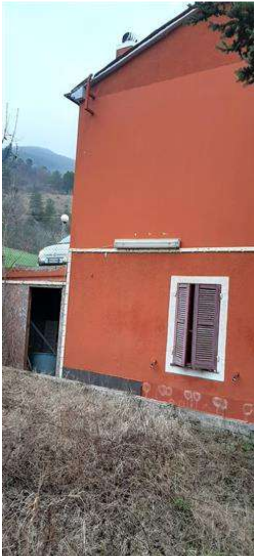
Scatto dal piano seminterrato verso il lato destro
