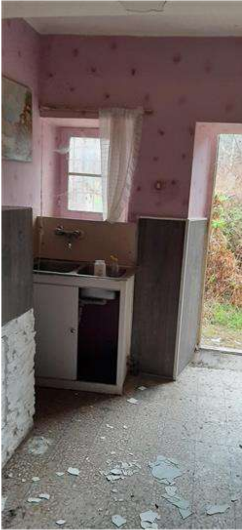
cucina al piano seminterrato
