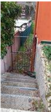
scala esterna tra il piano terra e il piano seminterrato
