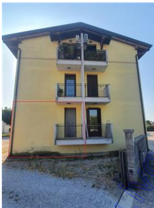
vista laterale alloggio
