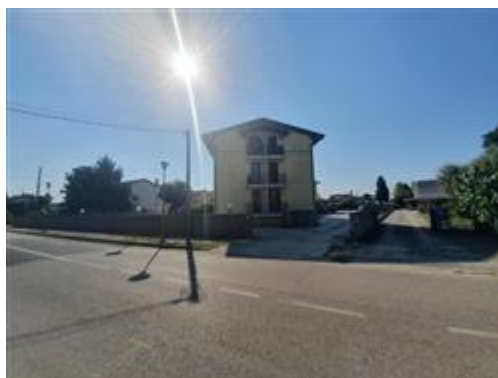
vista condominio "Residenza la Luna" da fronte strada
