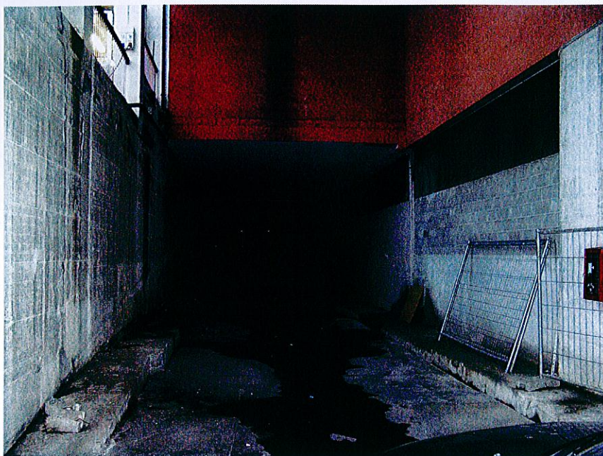
FOTO 1: Vista esterna verso sud; zona rampa demolita
