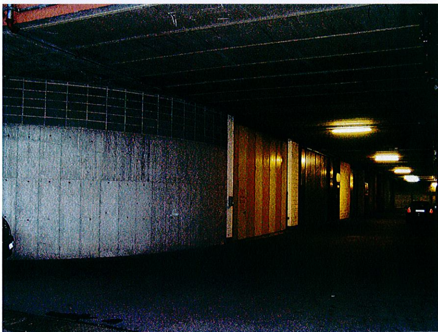
FOTO 2: Vista esterna: corsia veicolare
