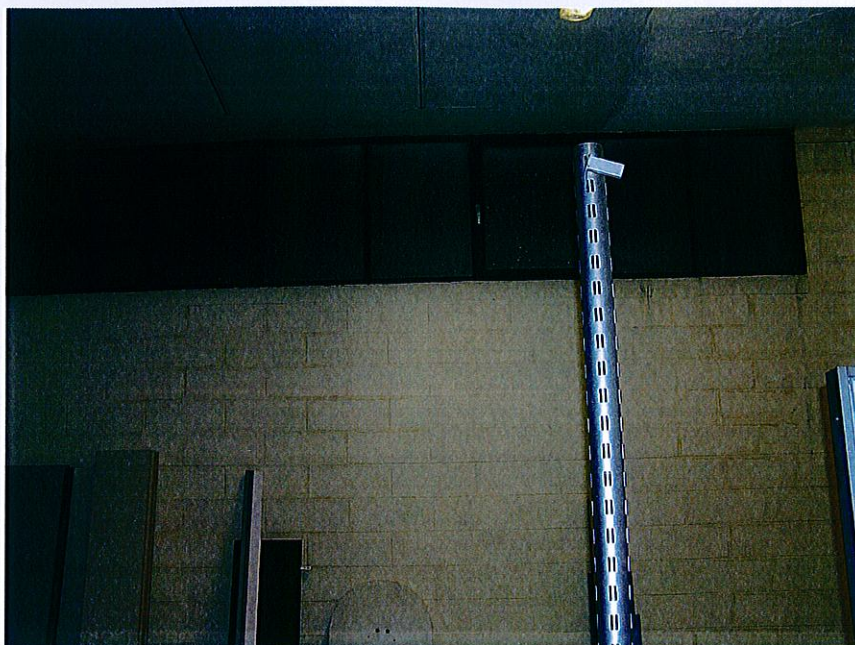
FOTO 3: Vista interna verso sud; finestre ostruite
