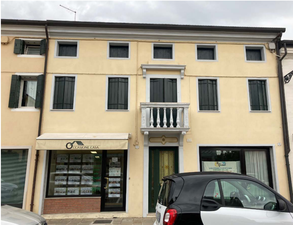
Foto n. 1: Vista del fabbricato
