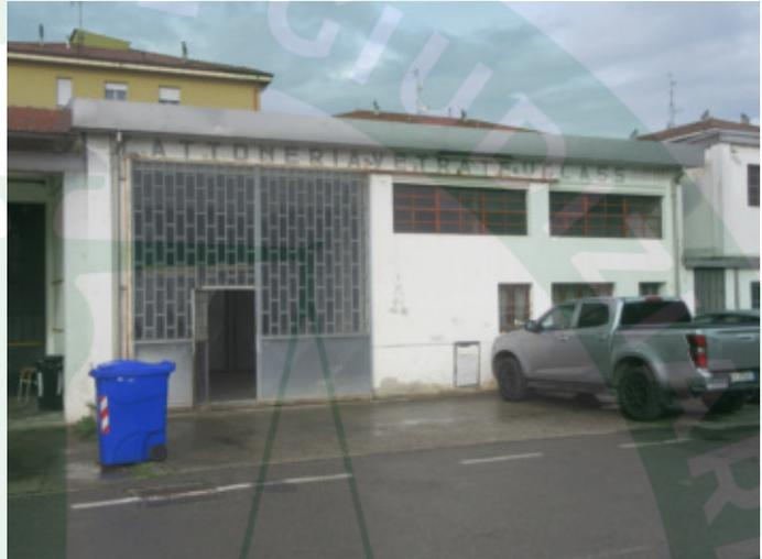
L'edificio è costituito da un tipico capannone ad un piano, di forma rettangolare allungata con orientamento principale est-ovest, con struttura portante a telai prefabbricati in c.a., tamponature in laterizio intonacato e copertura curva con manto superiore in tegole marsigliesi. Presenta accessi carrai e pedonali dalla Via Zandonai, strada privata condominiale in comproprietà pro quota tra le unità immobiliari interne al fabbricato.
