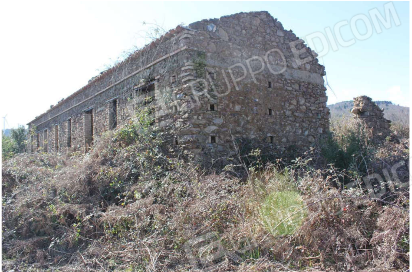
- Foto n° 1 - Comune di Valle Fiorita. Foglio 6, p.lla 2 - Fabbricato rurale diruto.
