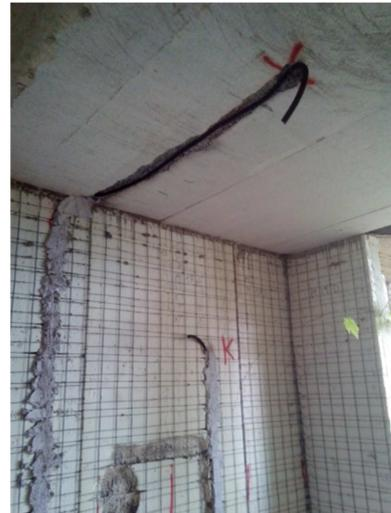
Foto 8 dettaglio impianto elettrico
