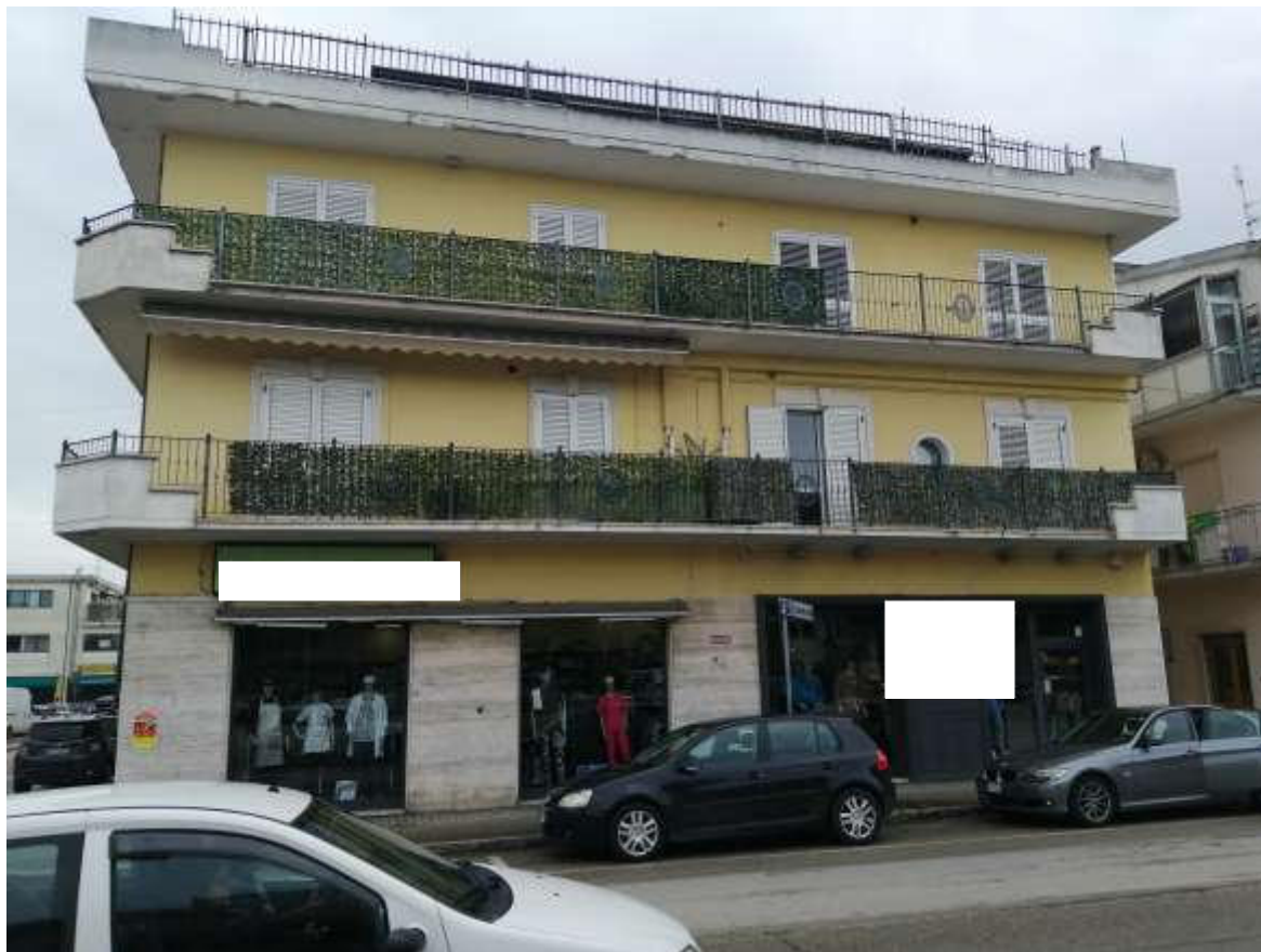
- Vista esterna del fabbricato su Via del Mare
