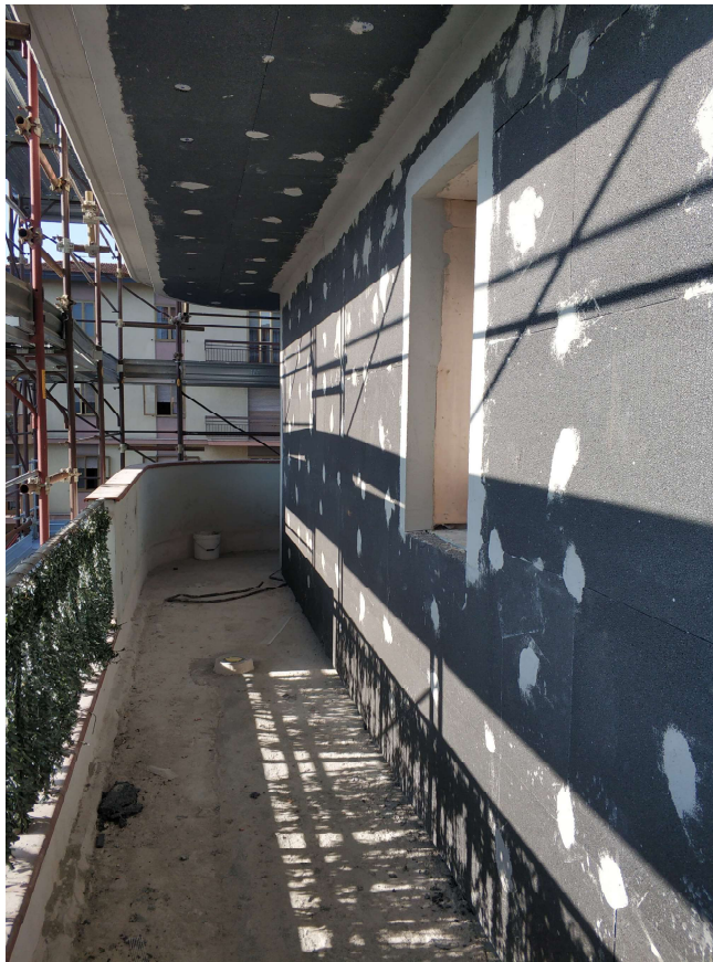
6 Vista Balcone (Lavori 110% Cappotto)
