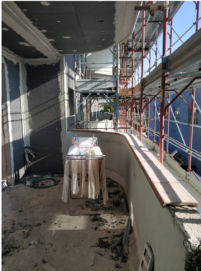
9 Vista Balcone (Lavori 110% Cappotto)
