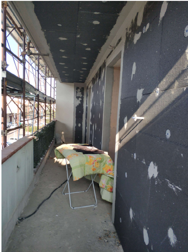
7 Vista Balcone (Lavori 110% Cappotto)
