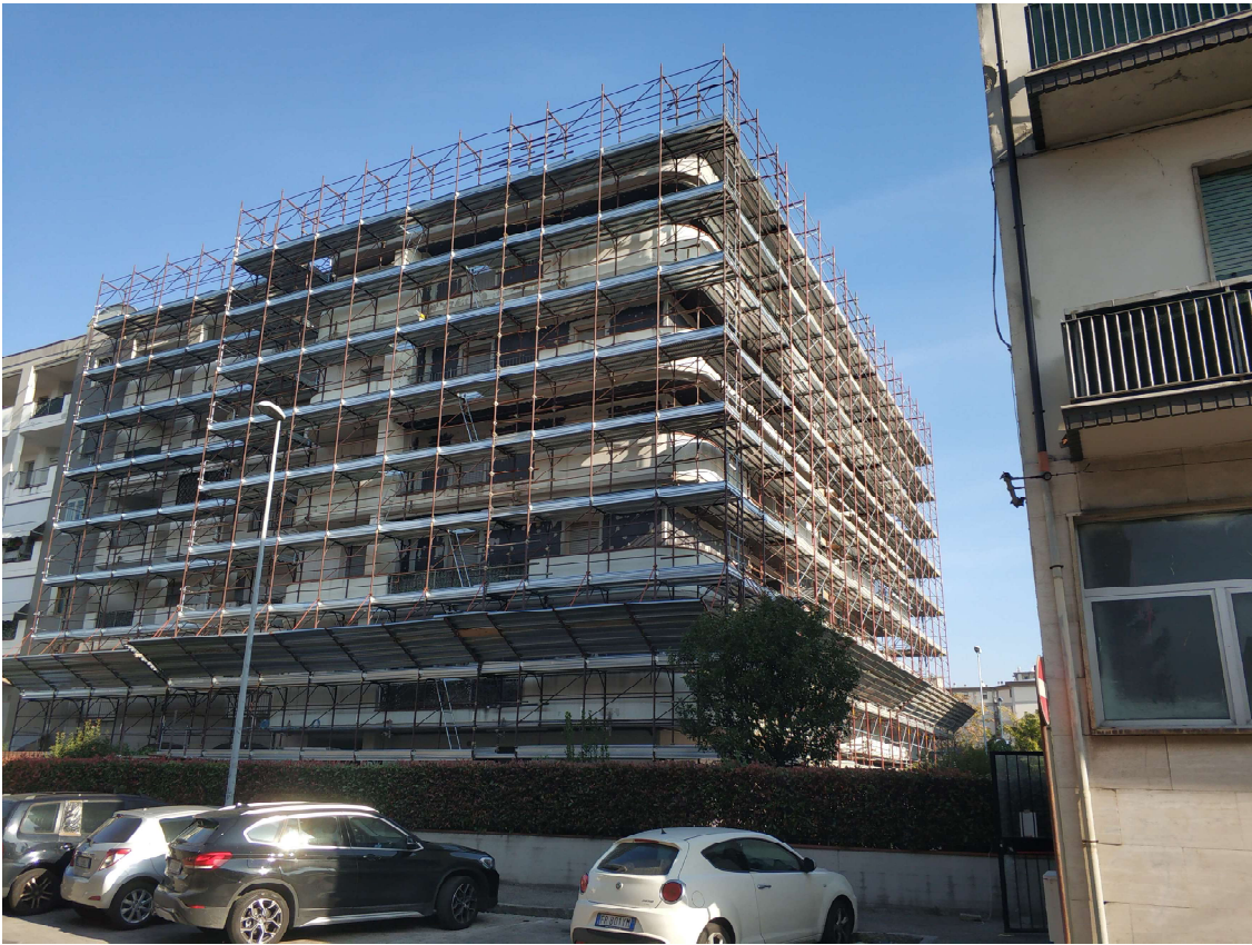
3 Vista facciata principale
