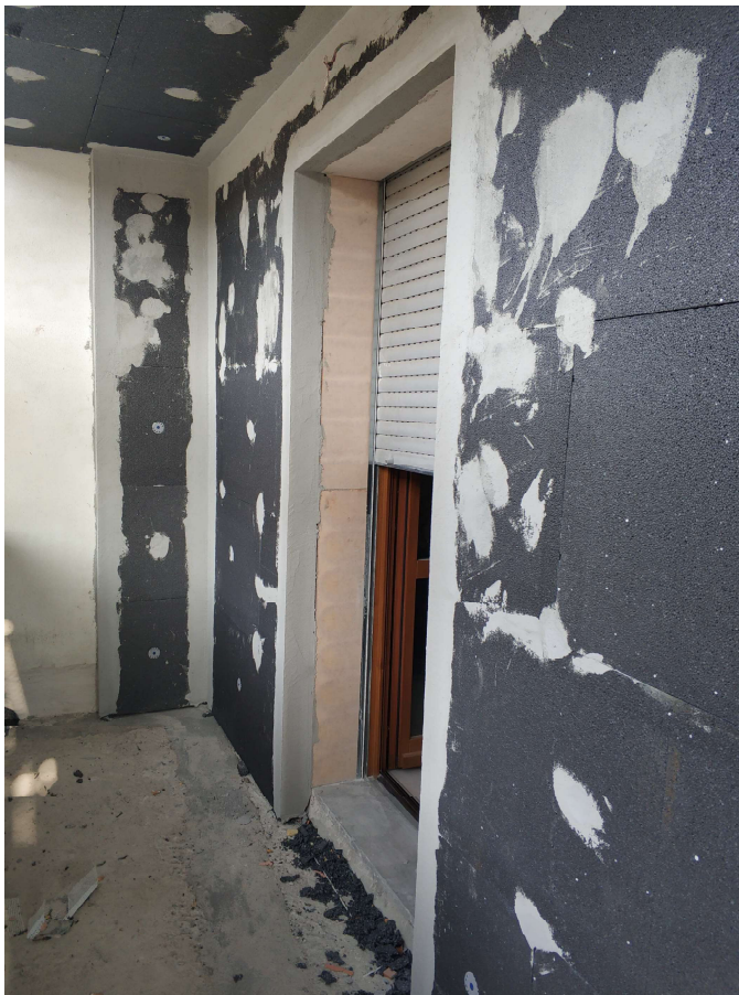
8 Vista Balcone (Lavori 110% Cappotto)
