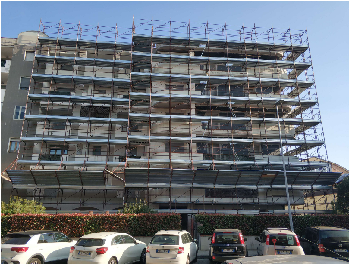
2 Vista facciata principale
