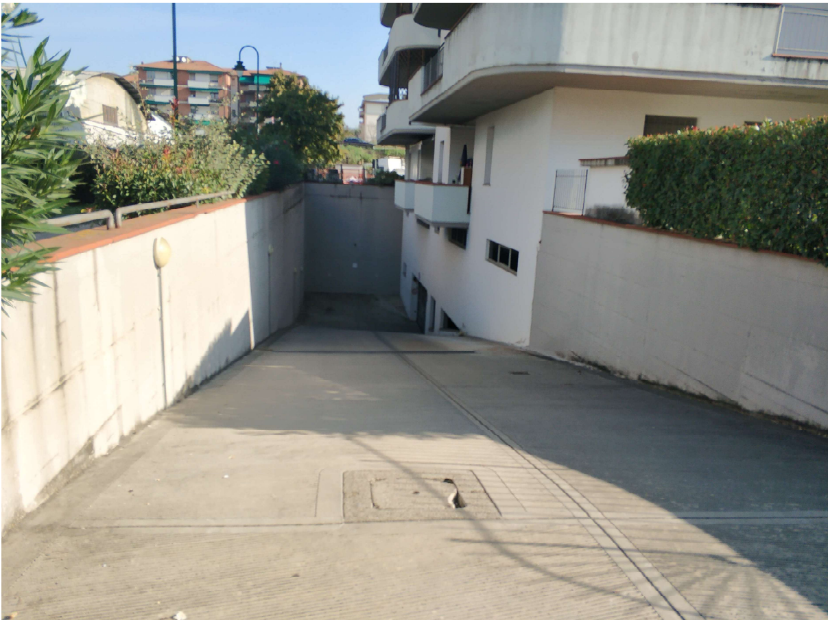
20 Vista Rampa Carrabile
