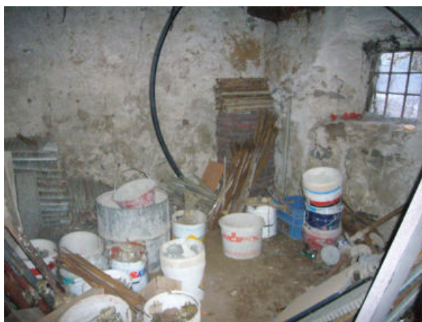
Ripostiglio a piano terra
