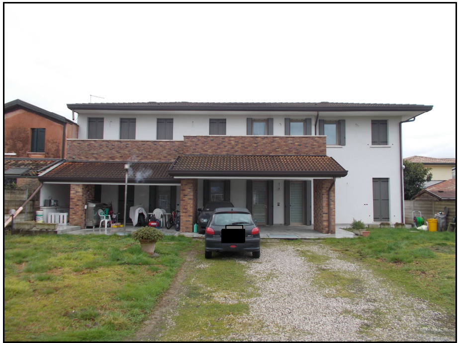
Foto 3-- LOTTO 2-- Vista frontale da nord
