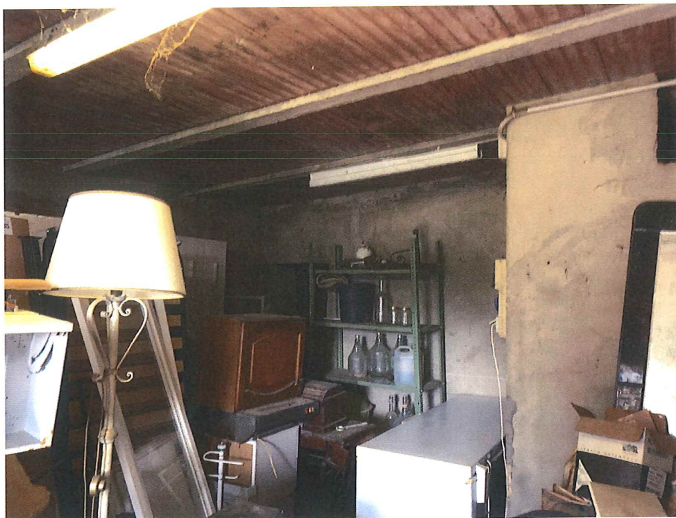
Foto n. 23 – Assisi. Edificio n. 1.
