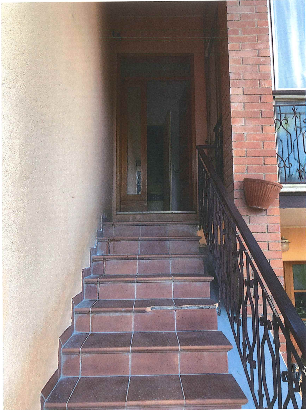
Foto n. 27 – Assisi. Edificio n. 2: particolari scala esterna e portone ingresso al piano primo.
