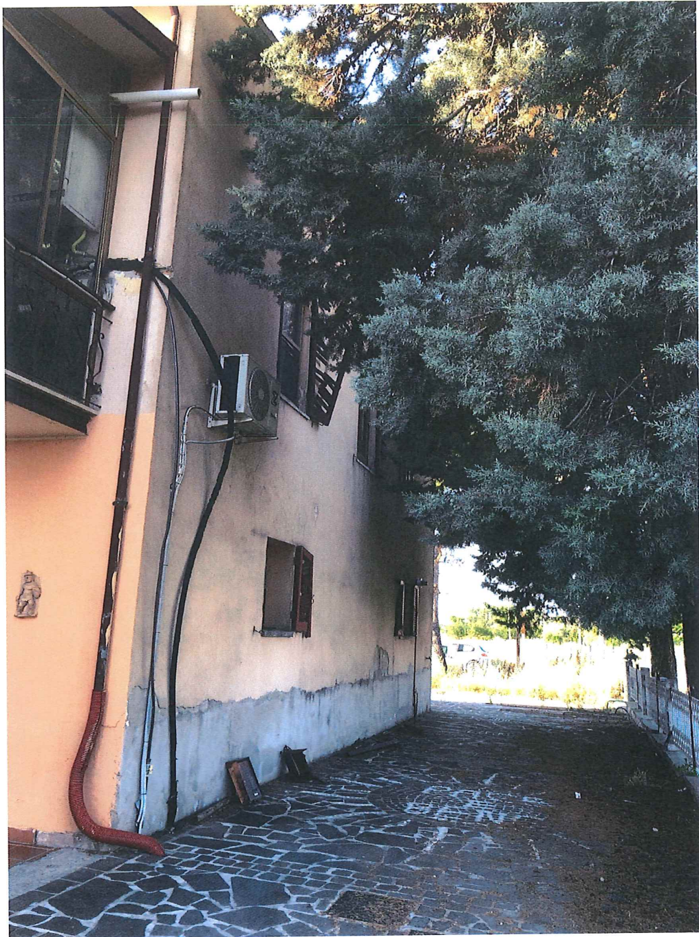
Foto n. 20 – Assisi. Edificio n. 2: prospetto lato strada (sud-est).
