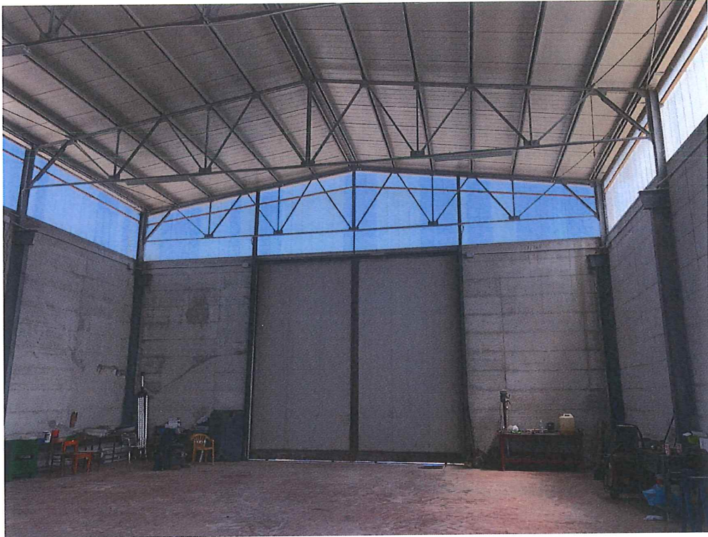
Foto n. 11 – Bettona. Interno capannone: particolari strutture.
