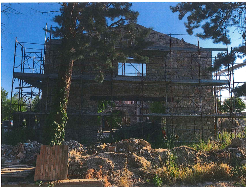
Foto n. 56 – Assisi. Edificio n. 3: facciata nord-est (lato edifici nn. 1 e 2).
