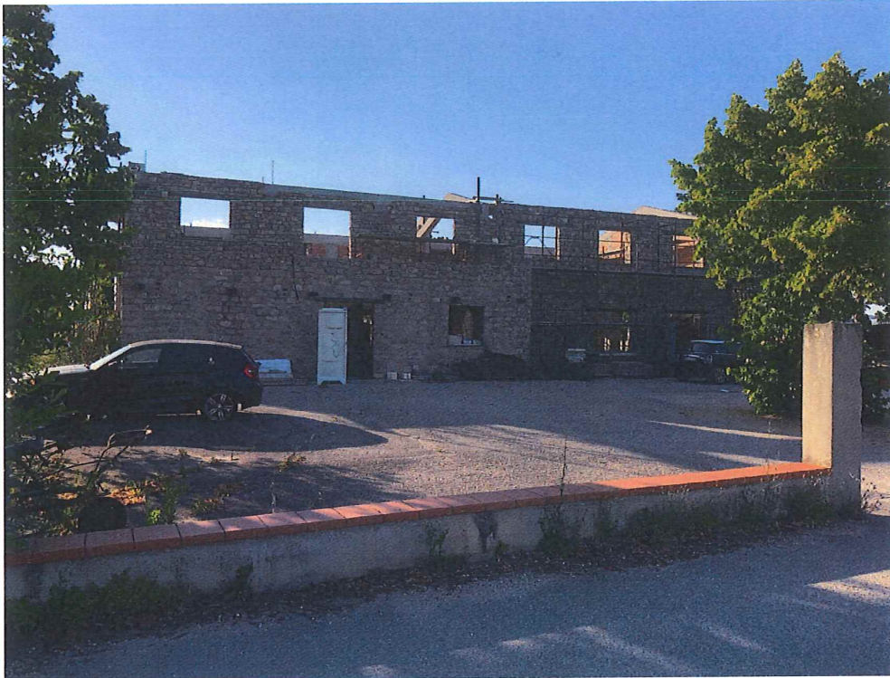
Foto n. 53 – Assisi. Come foto precedente: edificio n. 3 (frontestrada).
