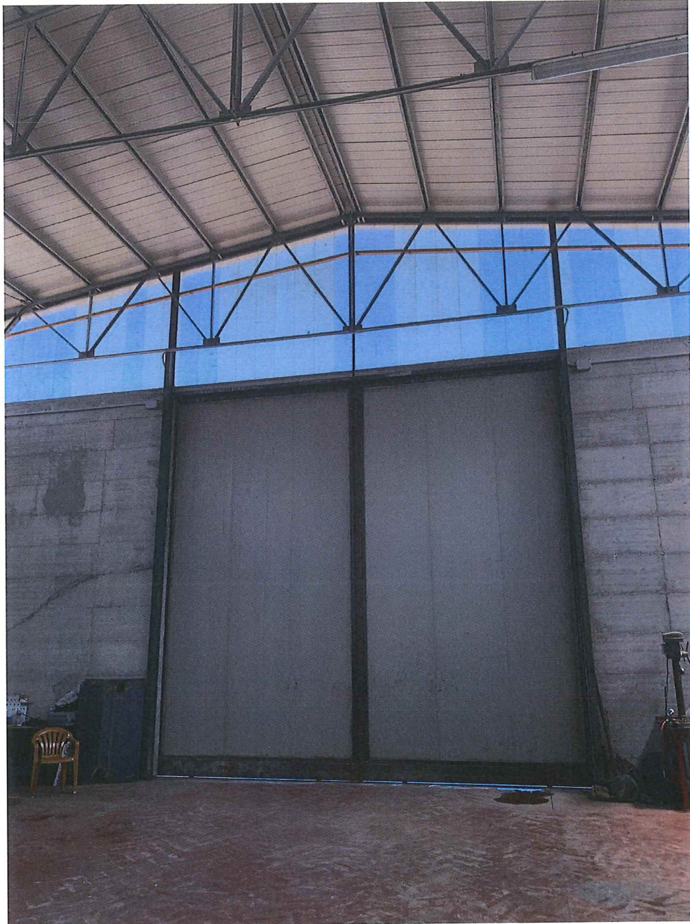
Foto n. 14 – Bettona. Interno capannone: particolare portone.
