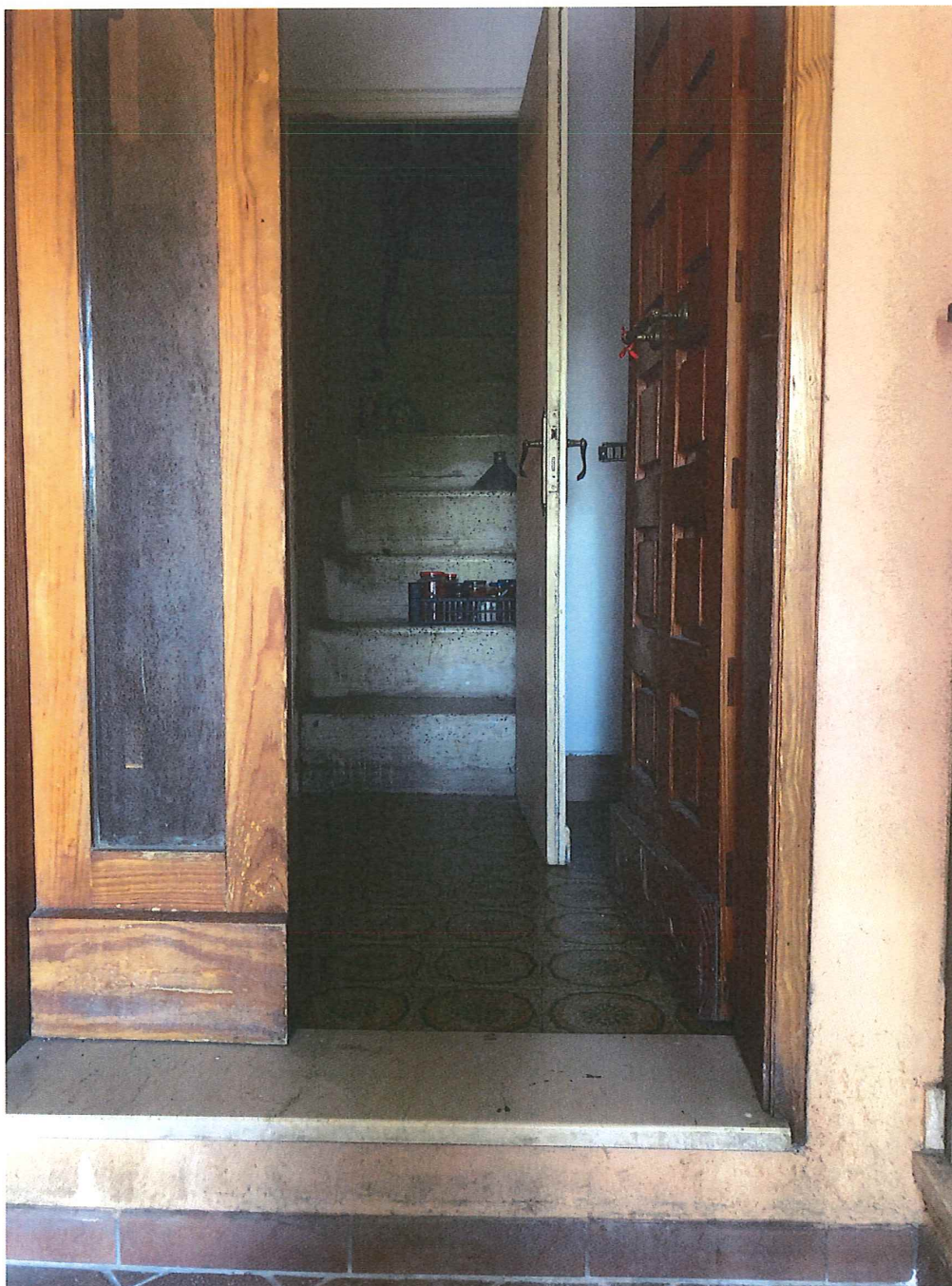
Foto n. 28 – Assisi. Edificio n. 2, come foto precedente: particolare ingresso comune e (sullo sfondo) scala interna che conduce al piano secondo (soffitta).
