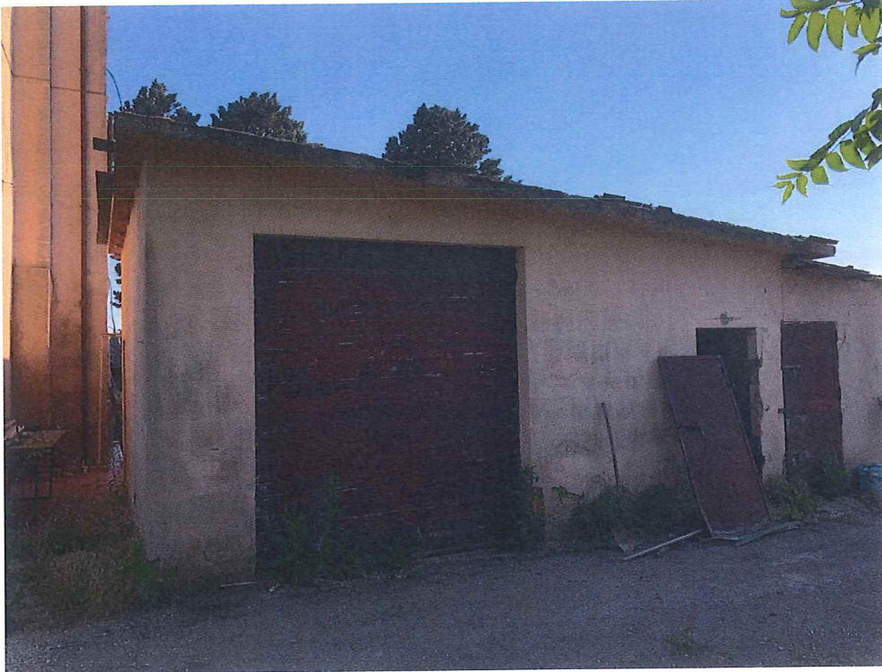
Foto n. 21 – Assisi. Edificio n. 1: retroprospetto (nord-est).
