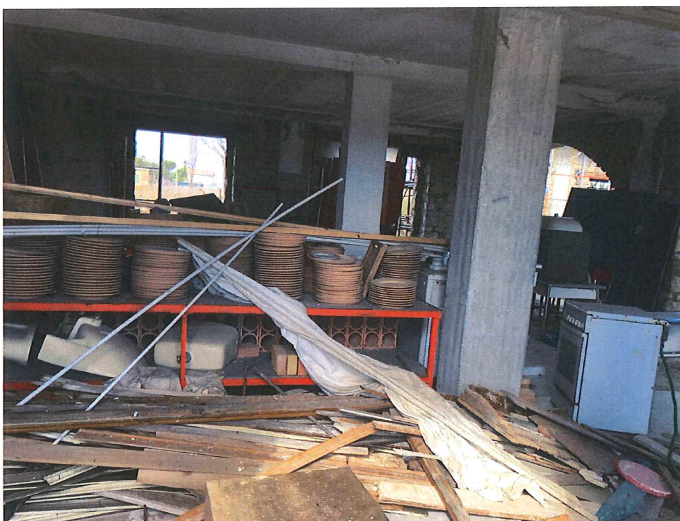
Foto n. 58 – Assisi. Edificio n. 3: particolari strutture.
