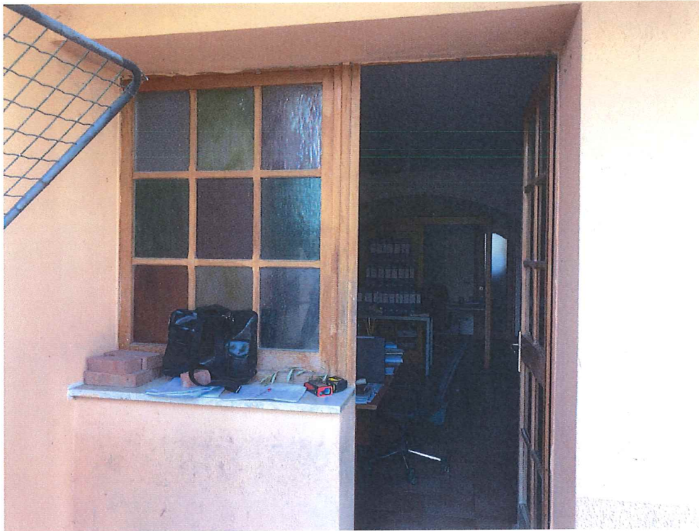
Foto n. 39 – Assisi. Edificio n. 2 - sub. 10: particolare ingresso (lato sud-ovest).
