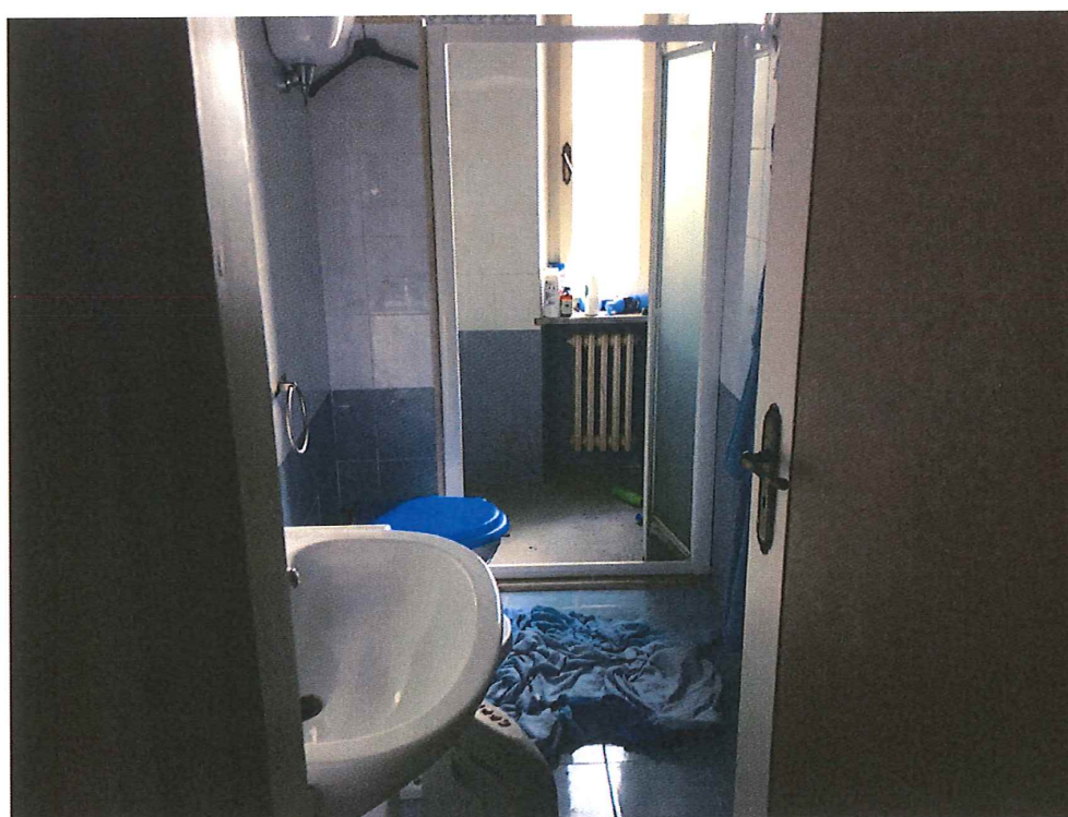
Foto n. 36 – Assisi. Edificio n. 2 - sub. 8: bagno.
