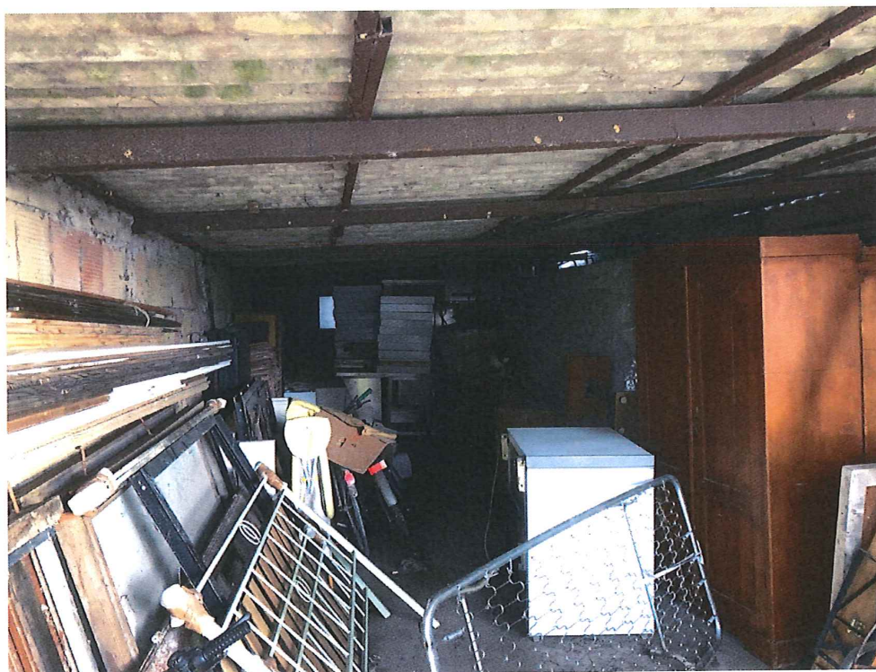
Foto n. 24 – Assisi. Edificio n. 1.
