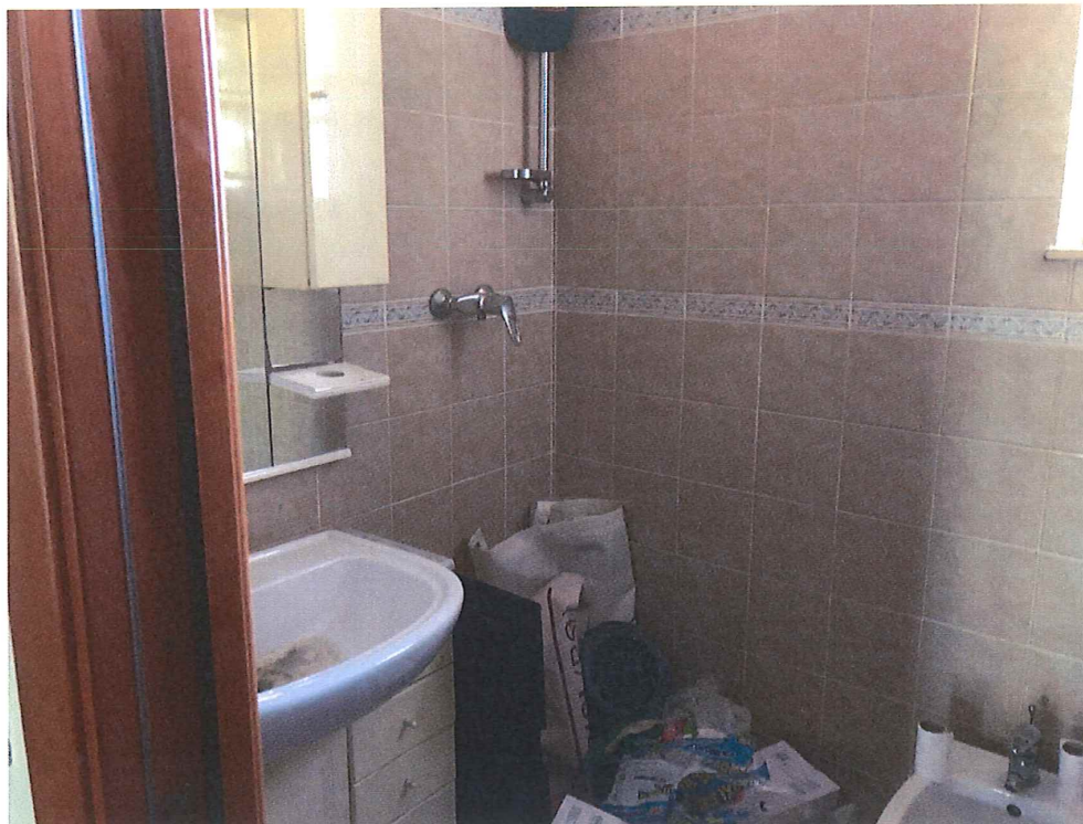
Foto n. 41 – Assisi. Edificio n. 2 - sub. 10: bagno.
