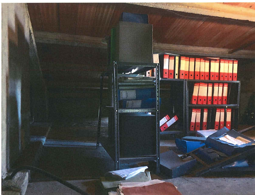
Foto n. 30 – Assisi. Edificio n. 2 - sub. 8: piano secondo soffitta.
