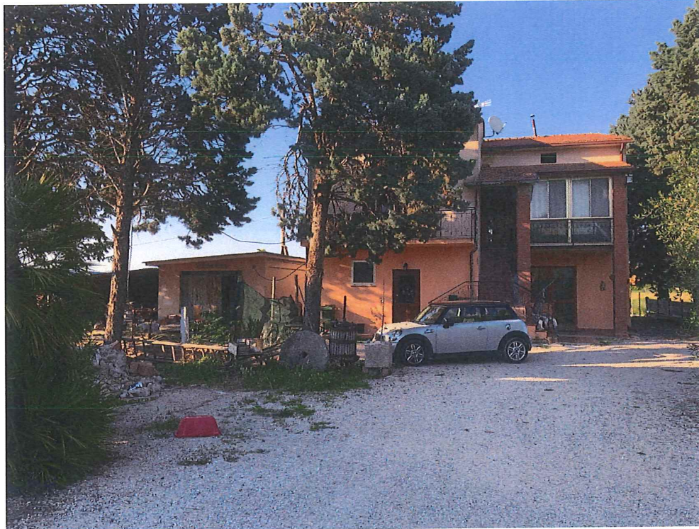
Foto n. 16 – Assisi. Edifici n. 1 (lato sinistro) e n. 2.
