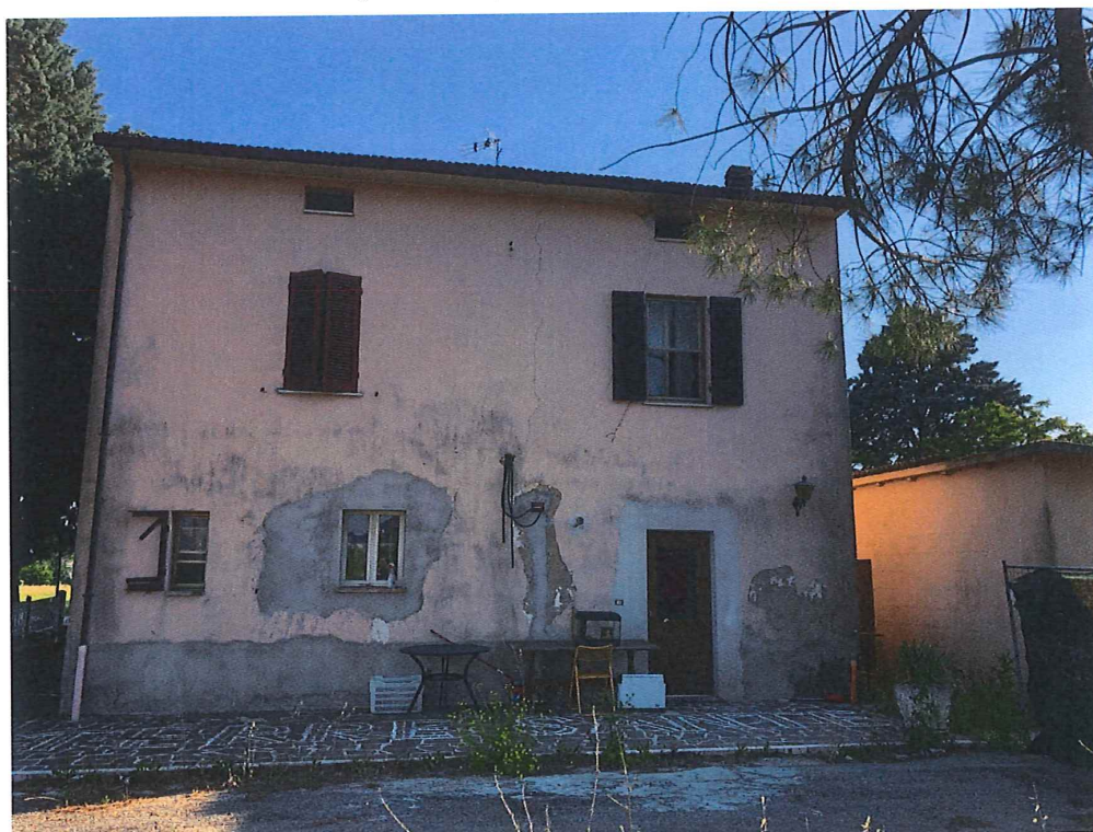
Foto n. 19 – Assisi. Edificio n. 2: retrospetto (nord-est).
