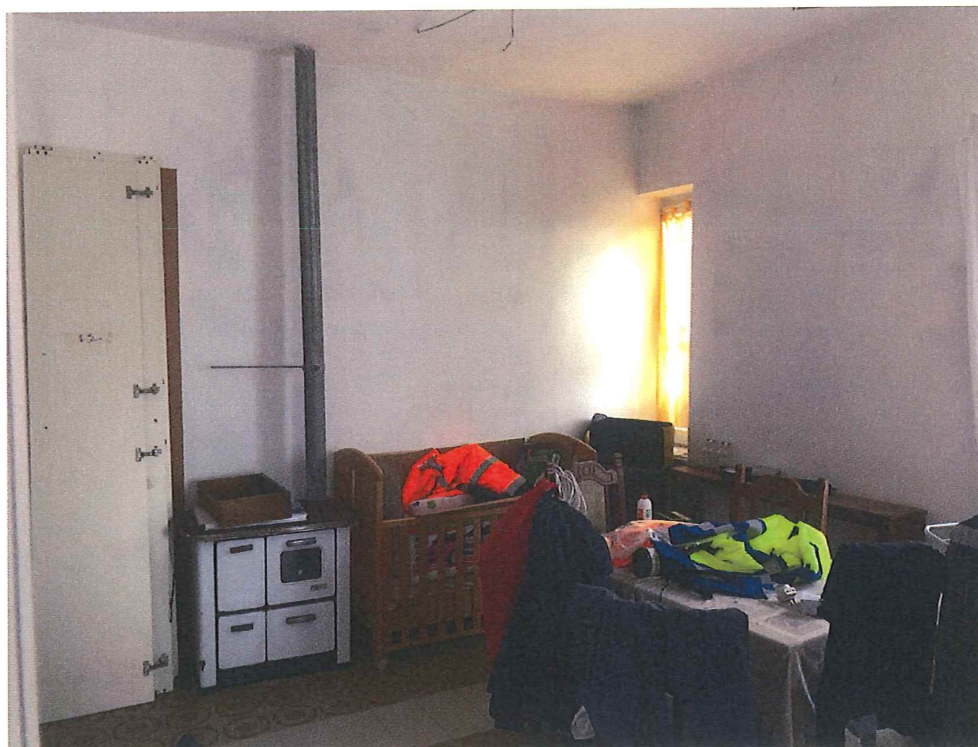
Foto n. 35 – Assisi. Edificio n. 2 - sub. 8: cucina-soggiorno.
