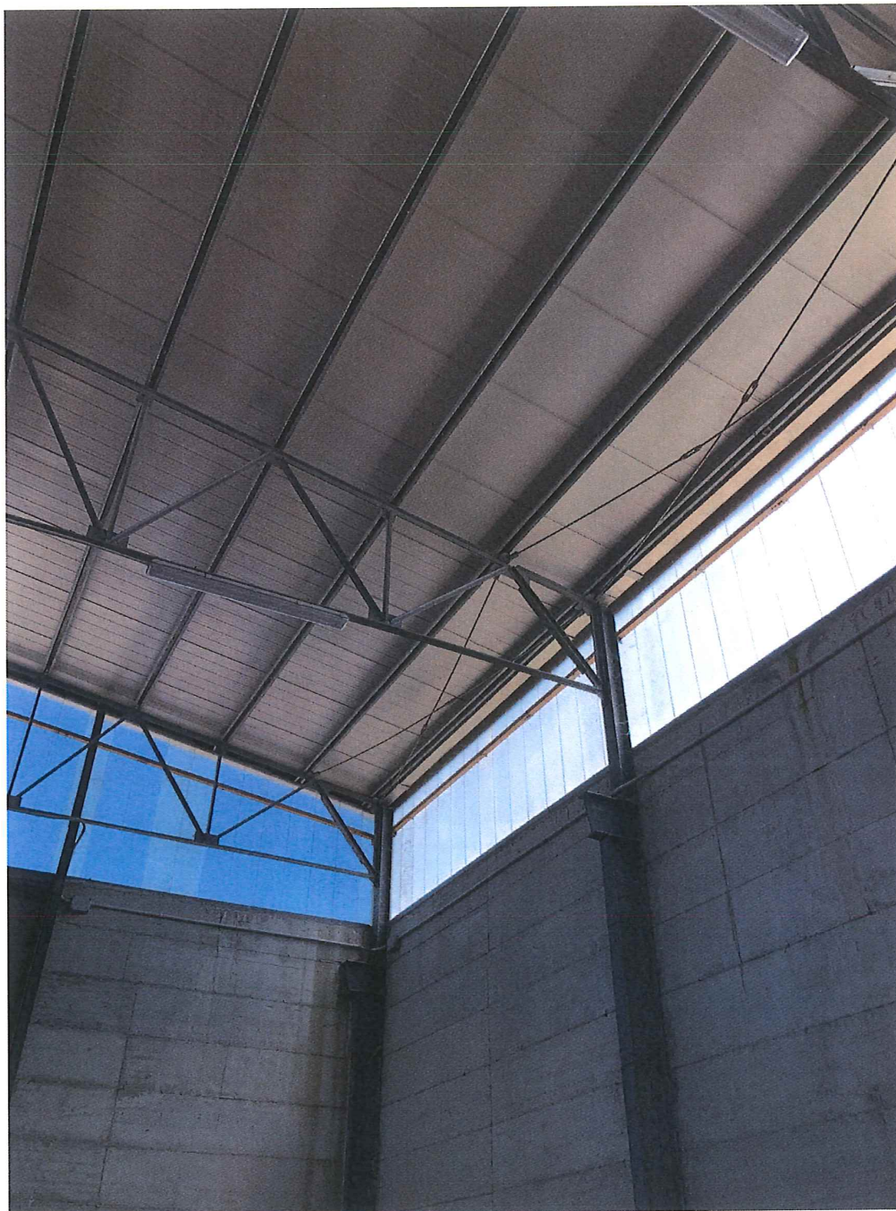
Foto n. 13 – Bettona. Interno capannone: particolari strutture e finestrate.
