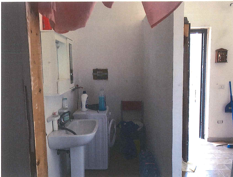
Foto n. 47 – Assisi. Edificio n. 2 - sub. 11: bagno.
