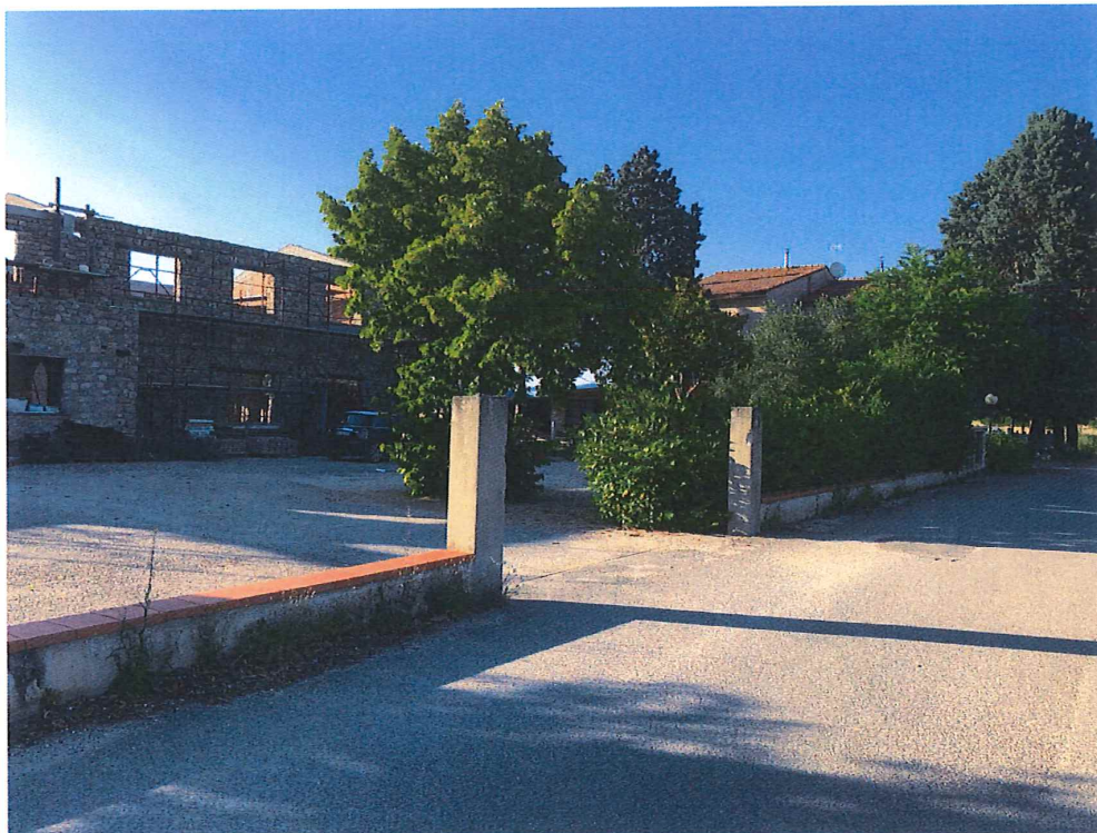
Foto n. 52 – Assisi. Particolare ingresso carrabile dalla strada alla proprietà (a sx edificio n. 3).
