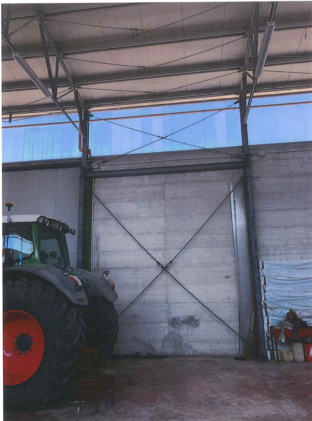
Foto n. 15 – Bettona. Interno capannone: particolare struttura in acciaio.
