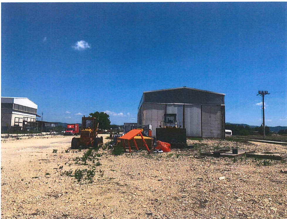
Foto n. 2 – Bettona. Facciata capannone lato ingresso (lato sud-ovest).
