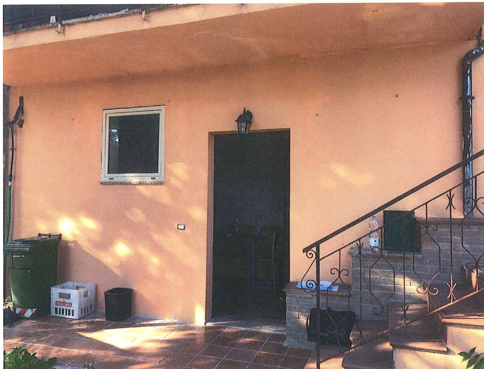
Foto n. 43 – Assisi. Edificio n. 2 - sub. 11: particolare ingresso piano terra.
