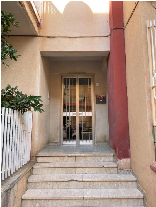
Ingresso Via Rosolino Colella
