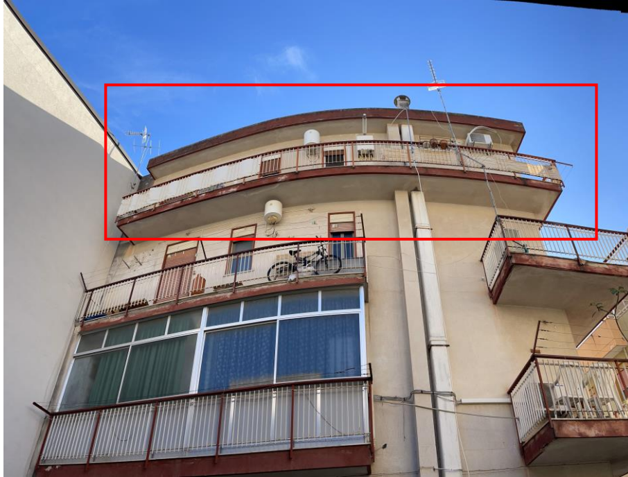
Vista da corte interna
