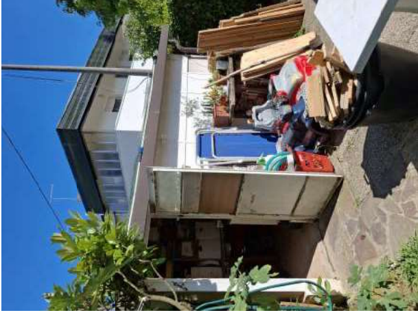
Foto 08 – veranda su corpo staccato (LOTTO 1)
