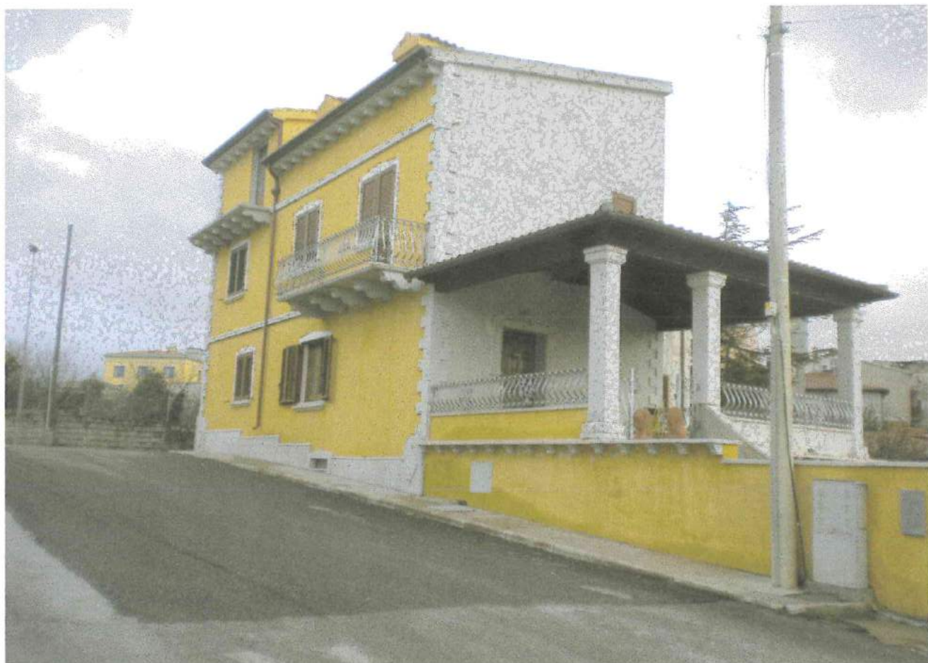
Foto n°6 – Veduta fabbricato unifamiliare – Via Mazzani-Via Fermi
