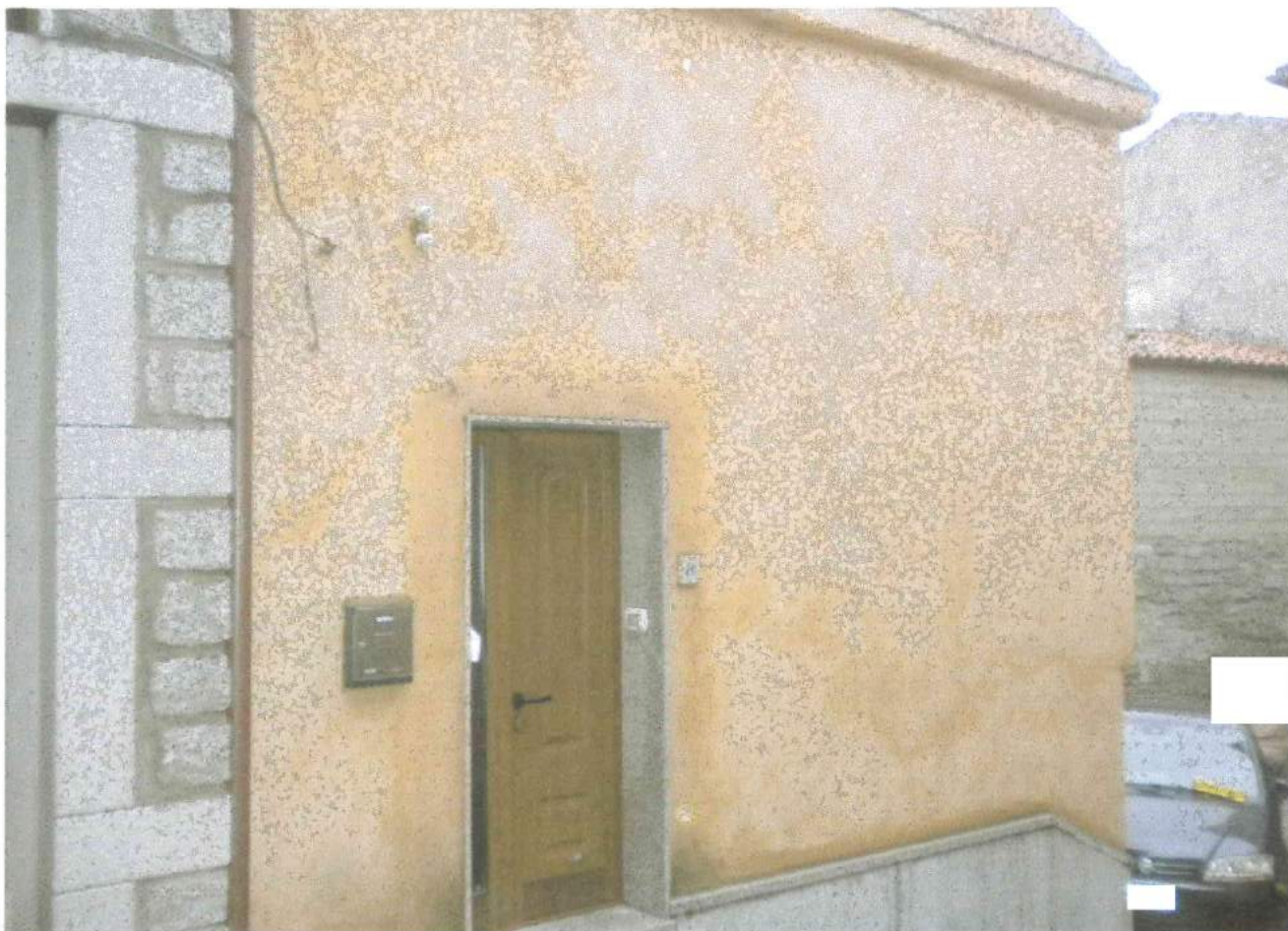
Foto n°9 – Veduta edificio in Via Margherita di Savoia n°8
