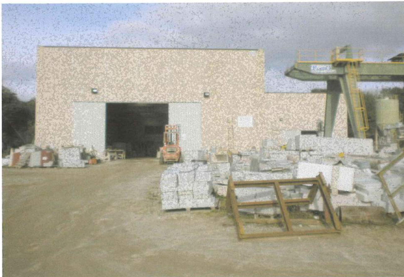
Foto n°1 – Veduta complesso artigianale per la lavorazione materiali lapidei – Reg. Intro e Serra
