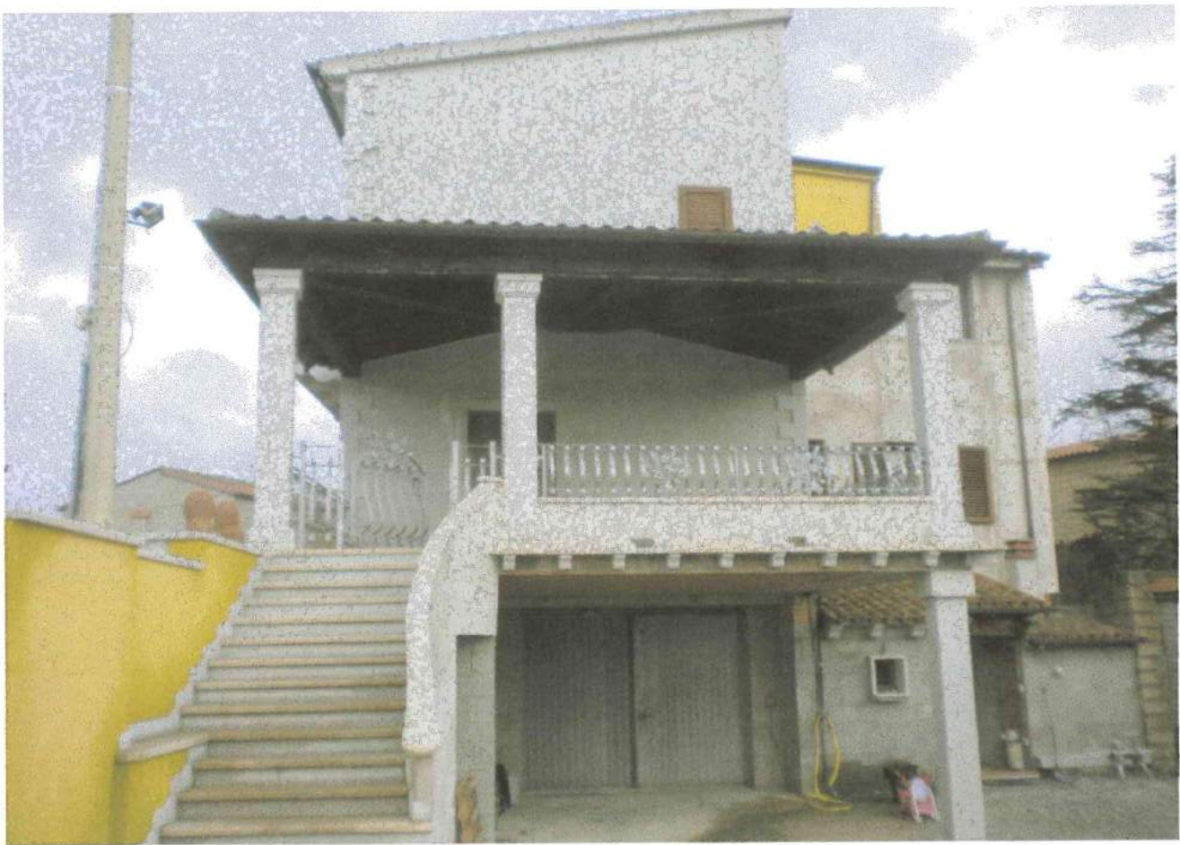
Foto n°5 – Veduta fabbricato unifamiliare – Via Mazzani-Via Fermi
