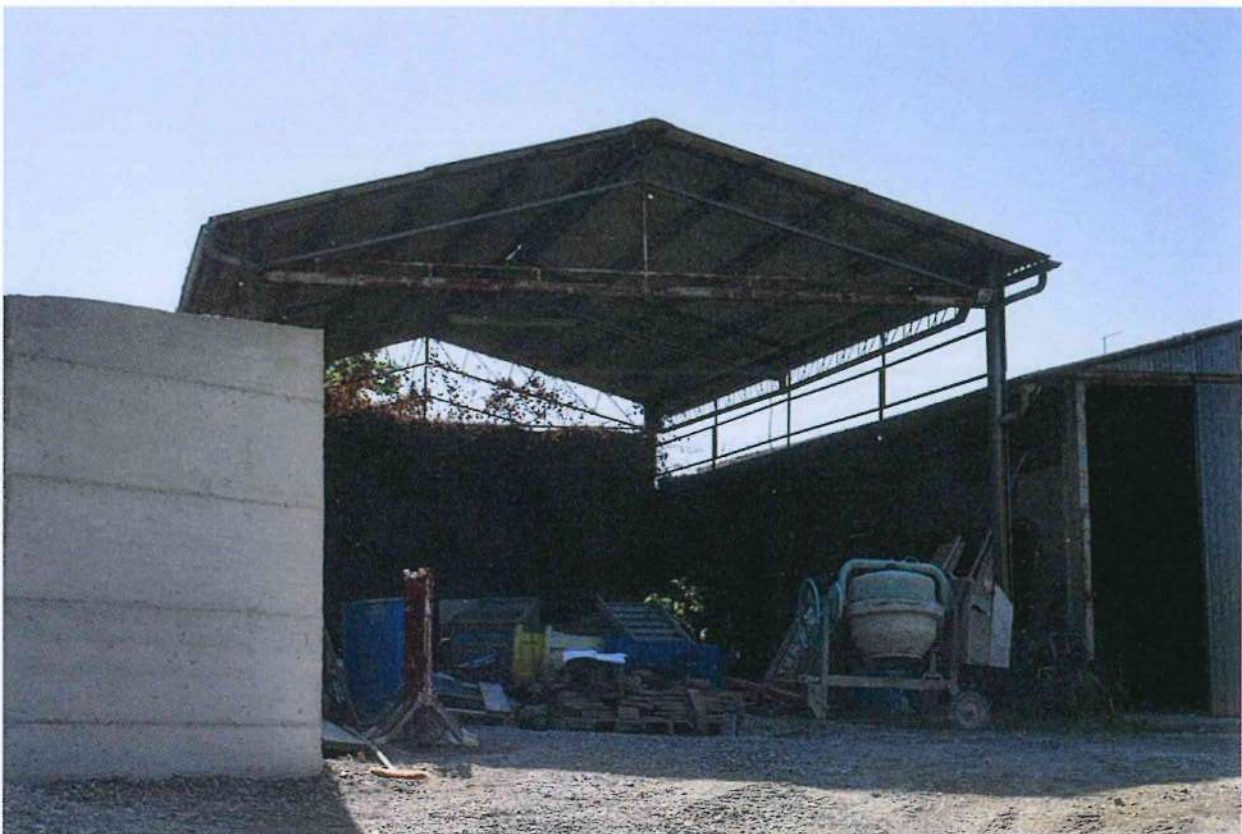
37. Dettaglio della rimessa attrezzi costituita da una tettoia
