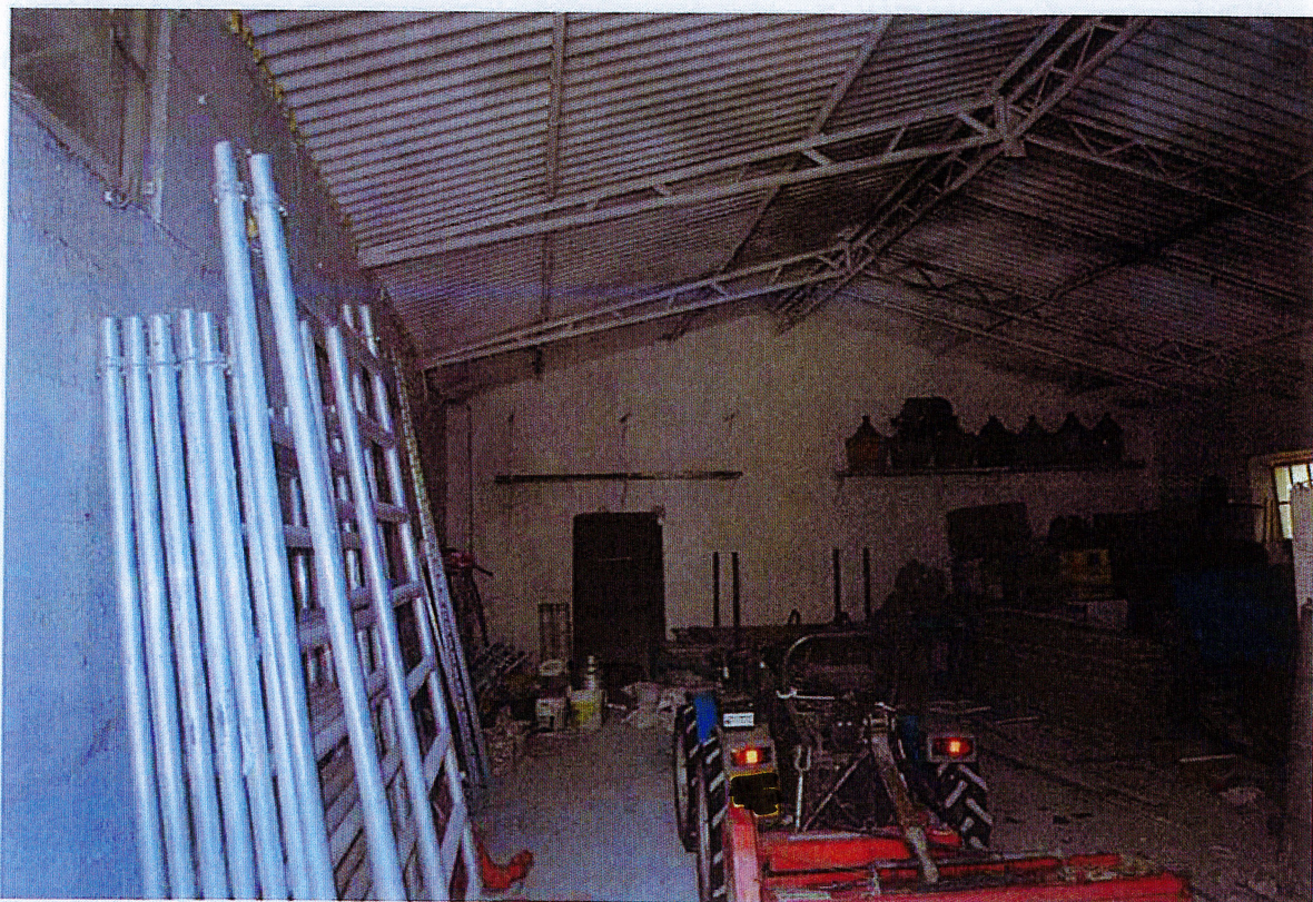
39. Porzioni interne della rimessa attrezzi (capannone)
