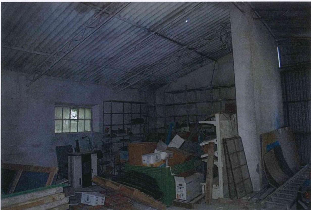
40. Porzioni interne della rimessa attrezzi (capannone)
