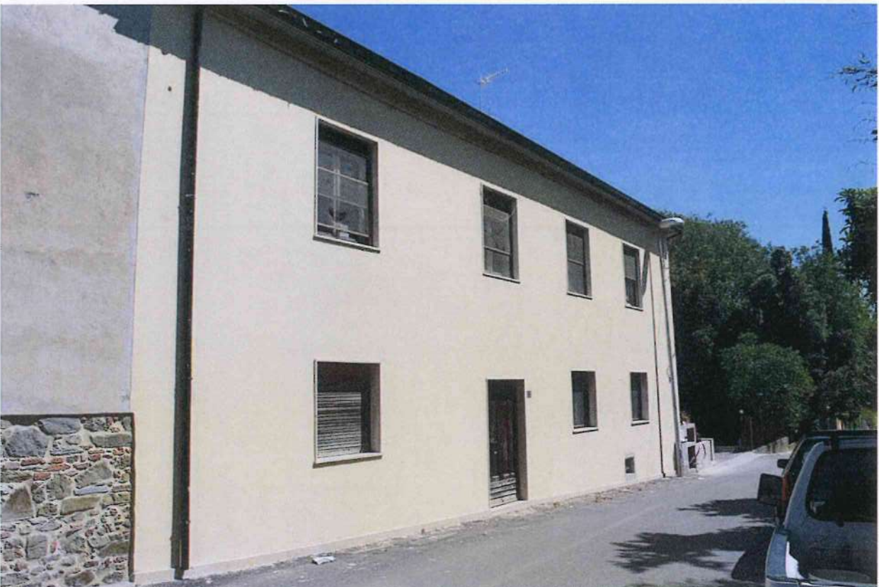
2. Veduta del lato sud da Via Circonvallazione (Istia d'Ombrone)
