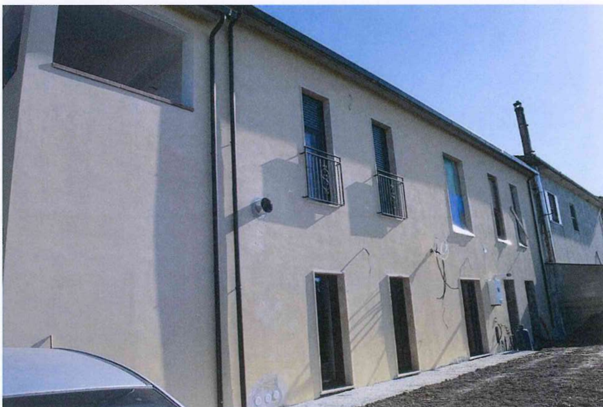
4. Veduta del lato nord
