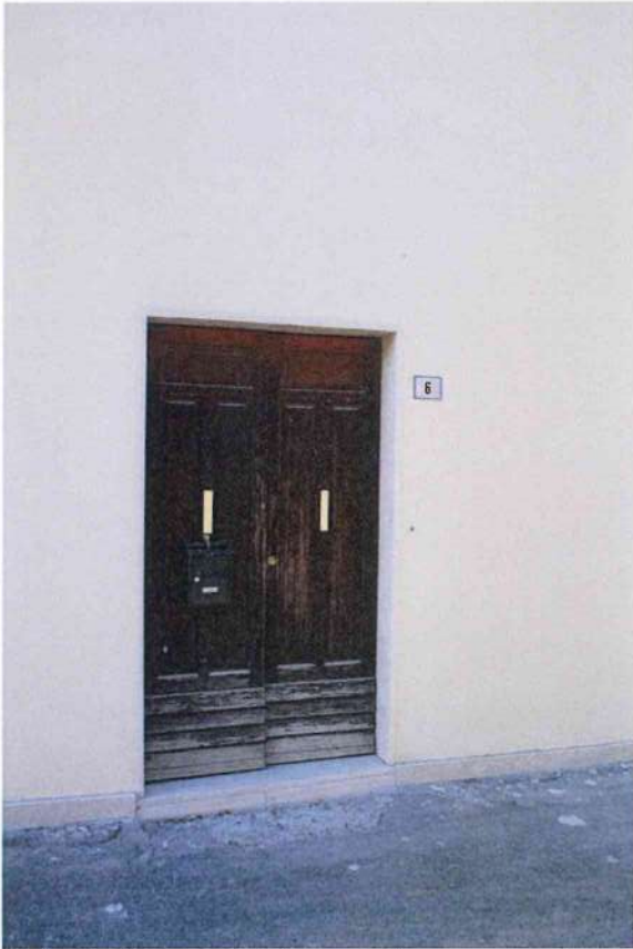
27. Porta di ingresso del vano scala comune agli appartamenti 3-4-5. Via Circonvallazione n. 6 (Istia d'Ombrone)
