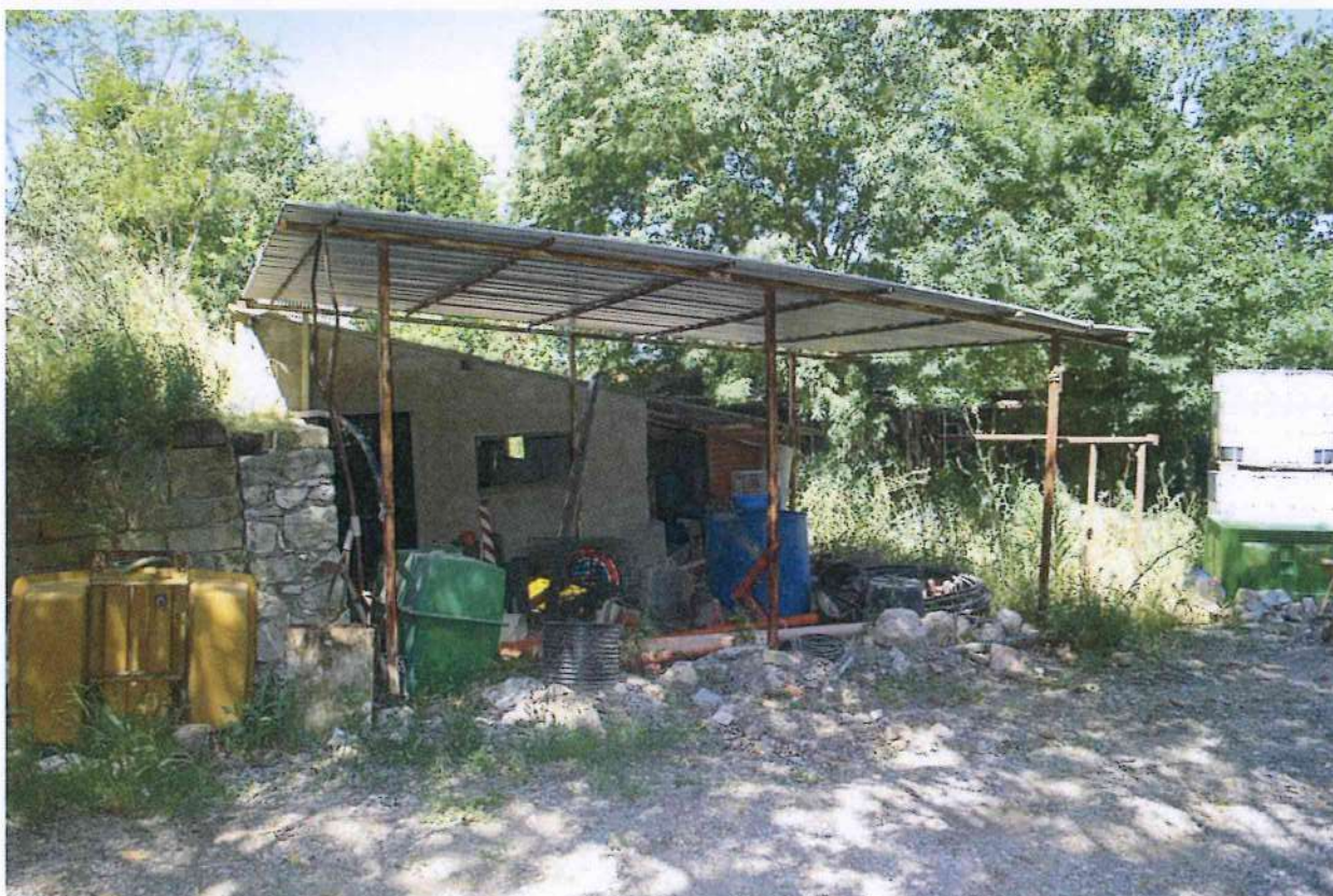
45. Veduta del lato est (la tettoia metallica in primo piano non è regolare)
