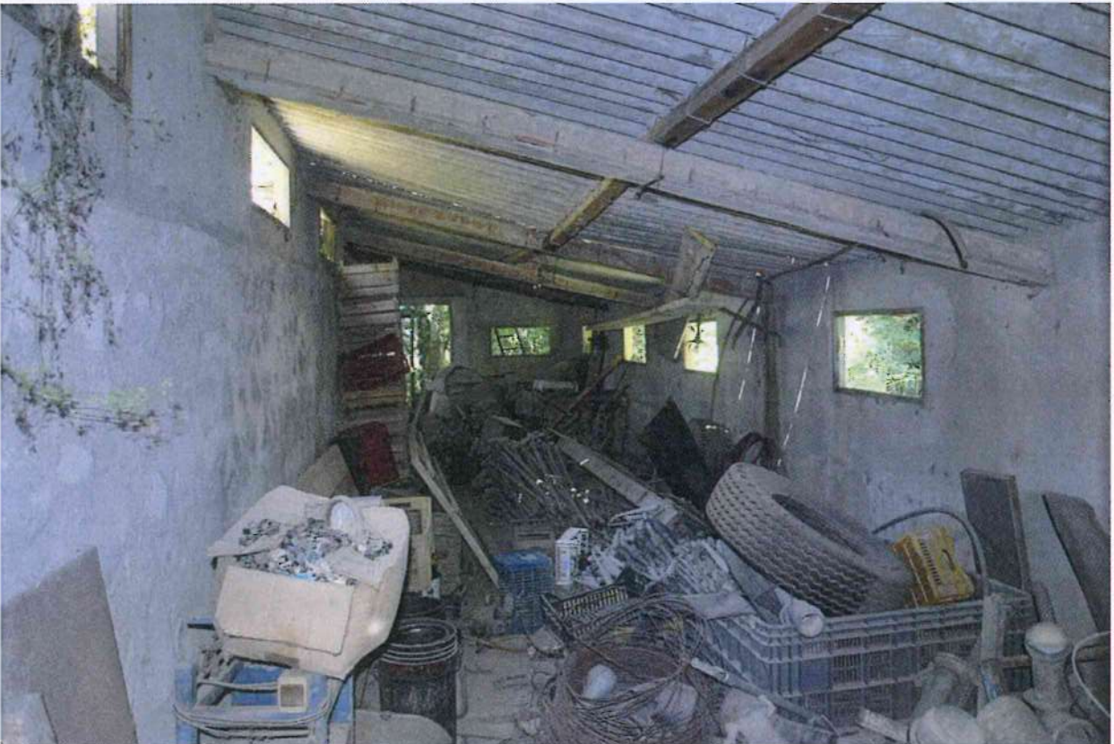
47. Veduta del vano interno
