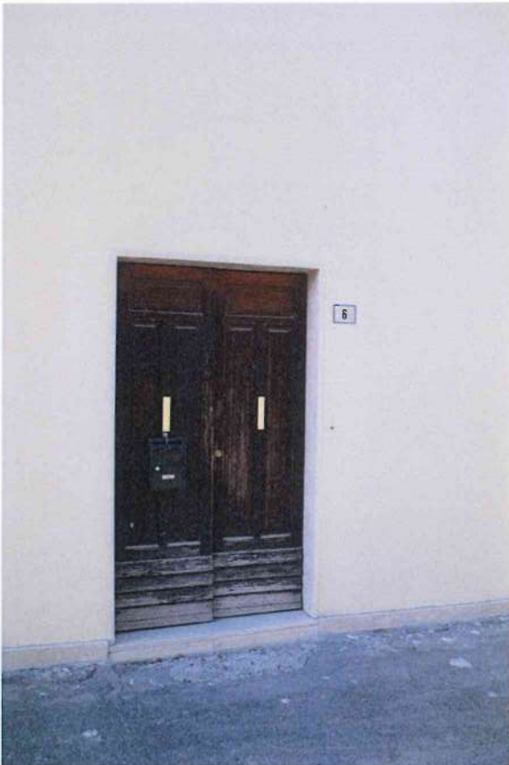
33. Porta di ingresso del vano scala comune agli appartamenti 3-4-5. Via Circonvallazione n. 6 (Istia d'Ombrone)
