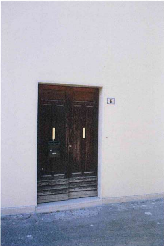
23. Porta di ingresso del vano scala comune agli appartamenti 3-4-5. Via Circonvallazione n. 6 (Istia d'Ombrone)
