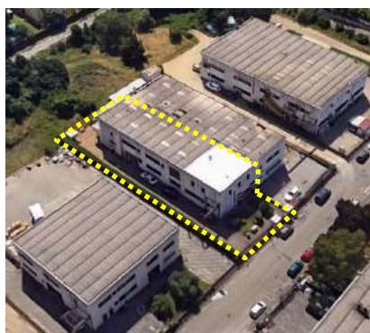
Lotto A) Fabbricato industriale
