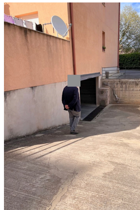
Figura 5 – vista della scivola di ingresso al piano seminterrato
