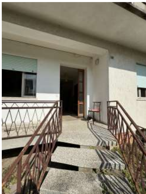
FOTO 6: vista scala esterna
