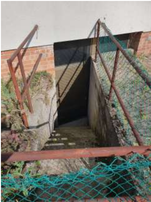
FOTO 4: vista scala piano interrato
