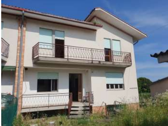
FOTO 3: vista fabbricato residenziale
