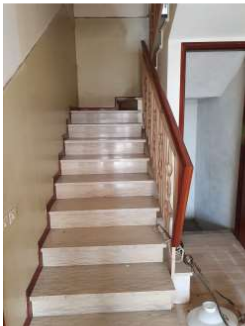
FOTO 12: vista vano scala
