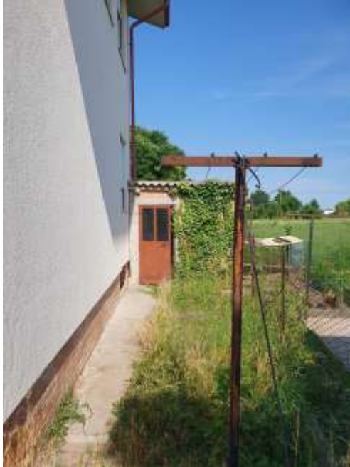
FOTO 25 : vista disimpegno esterno
